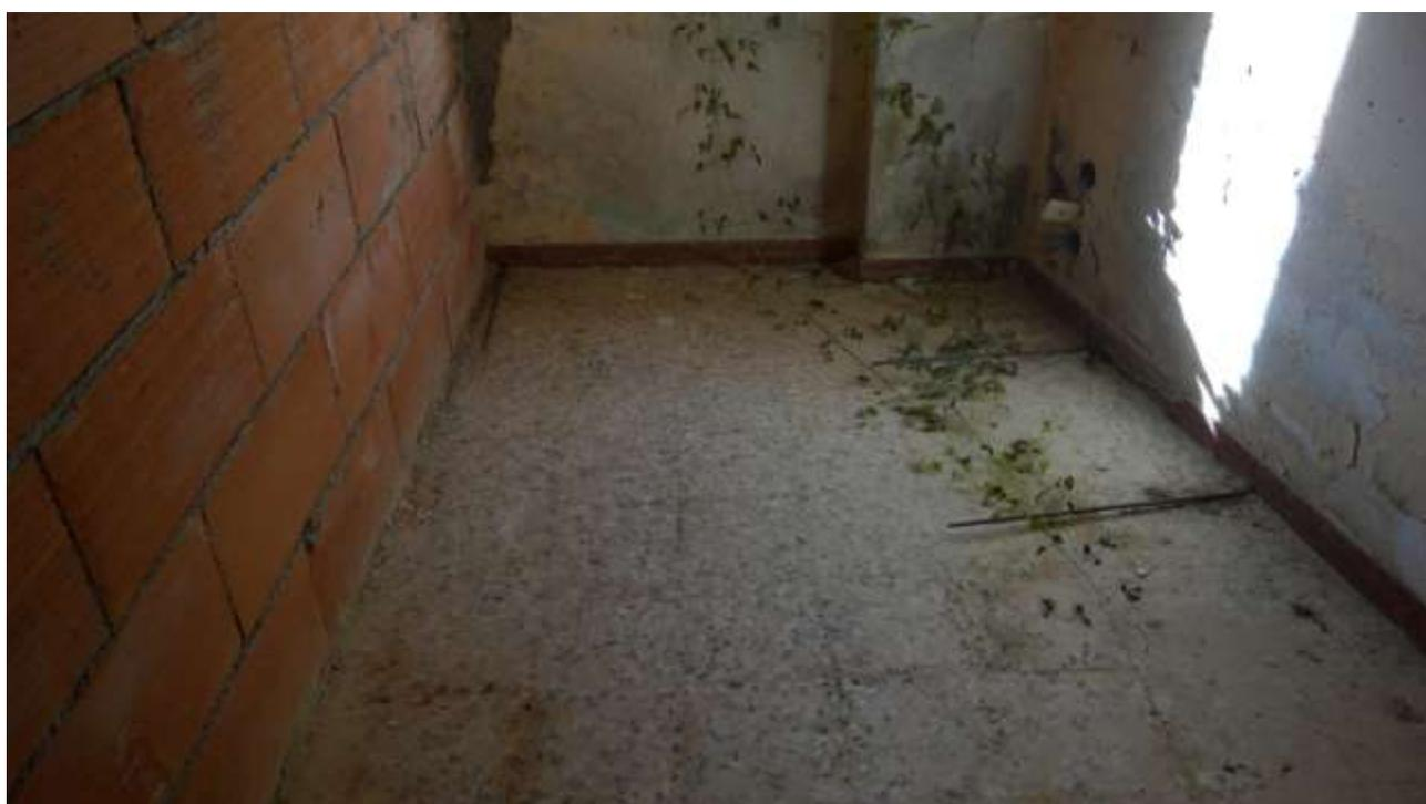
Foto n. 6 – Comune di Travesio (PN) – frazione Toppo - “Corte Dal Nodâr”- Lotto 3 – Foglio 8, Unità 7 – Piano terra – Particolare della vecchia pavimentazione e del nuovo tramezzo nello stesso vano.
