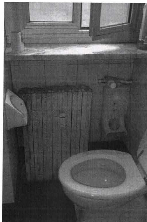
FOTO N. 6-7 – INTERNO - Bagno: Vista del locale e dettaglio del caloriferostaccato dall'impianto.
