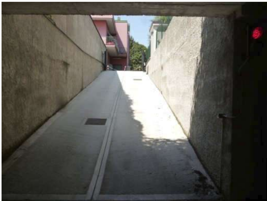
FOTO 3 - Rampa di ingresso ai box
