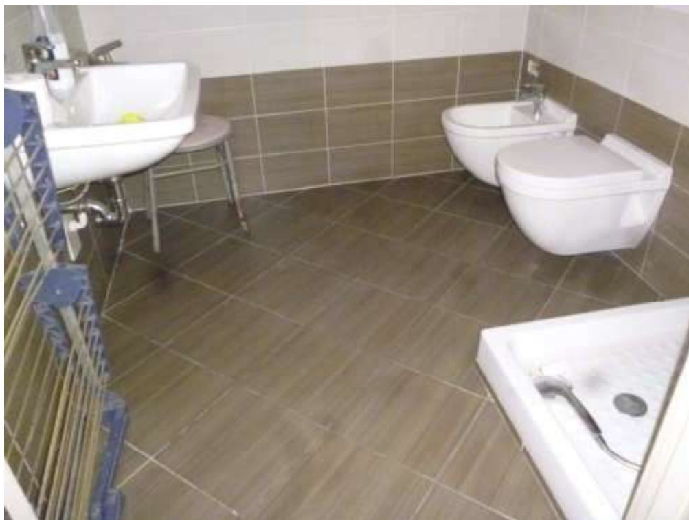
FOTO 19 - Box (!) Sub. 24. Il bagno
