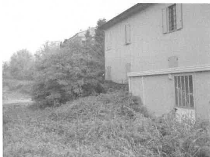
Foto n. 7 – Baracca di cantiere posta ai margini del fontanile canabagno
