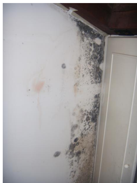
PARTICOLARE DELLE MURAATURE SOTTOTETTO
