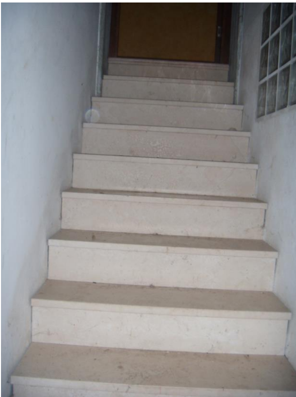
SCALA DI ACCESSO AL PIANO SCANTINATO
