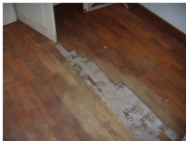
PARTICOLARE DELLA PAVIMENTAZIONE SOTTOTETTO
