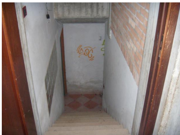
SCALA DI ACCESSO AL PIANO INTERRATO
