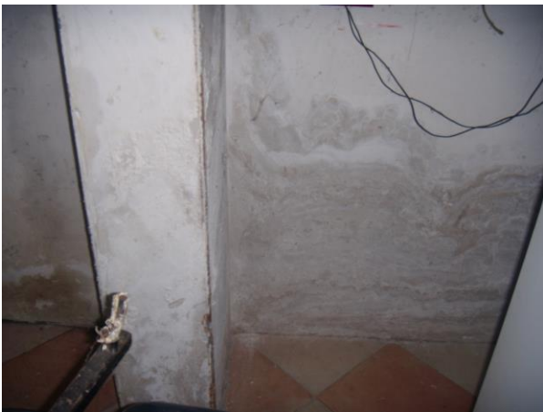
PARTICOLARE DELL'INTONACO A GESSO PIANO INTERRATO
