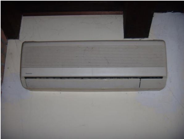
CILLER DI RAFRSCAMENTO SOTTOTETTO
