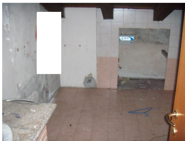
BAGNO NEL SOTTOTETTO
