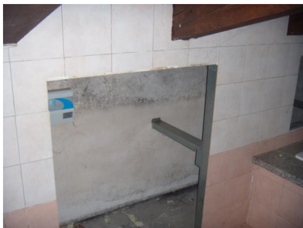
PARTICOLARE DEL BAGNO SOTTOTETTO
