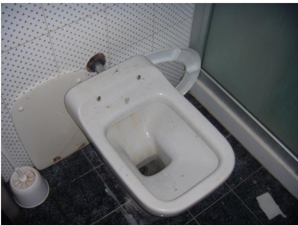
PARTICOLARE DEL WATTER BAGNO PIANO TERRA
