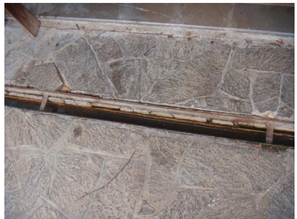
PARTICOLARE DELLA CANALETTA RACCOGLI ACQUE SU ACCESSO GARAGE
