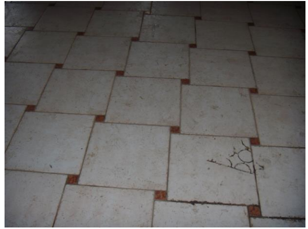
PARTICOLARE PAVIMENTAZIONE CUCINA/SOGGIORNO
