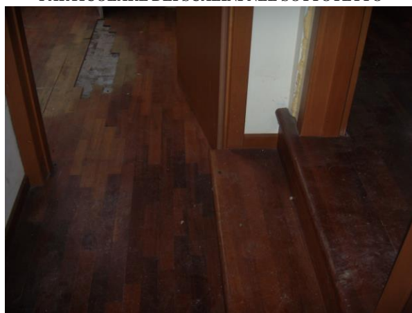
PARTICOLARE DEI SCALINI NEL SOTTOTETTO
