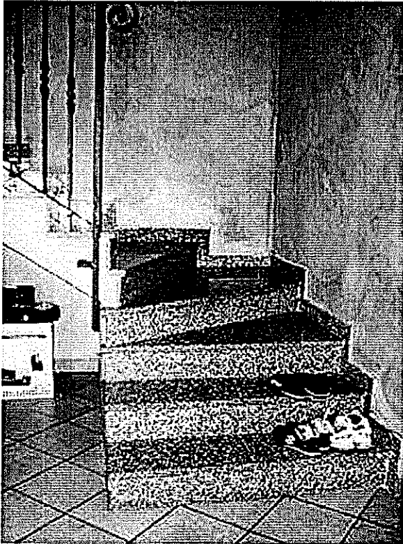
Foto n. 8 : scala accesso al piano primo
