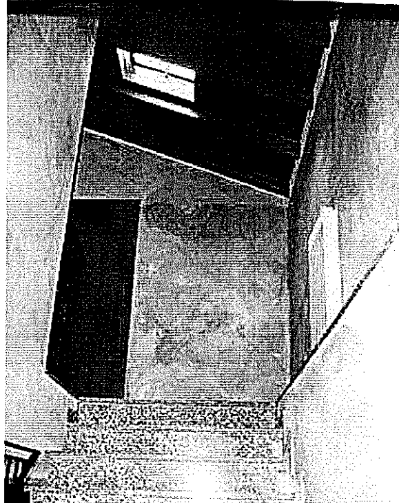
Foto n.9: sbarco scala accesso al piano primo
