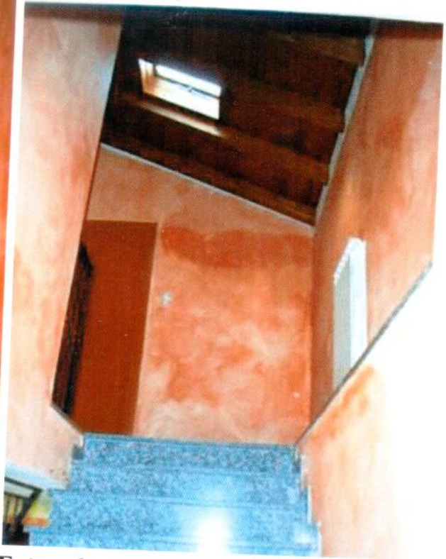
Foto n.9: sbarco scala accesso al piano primo
