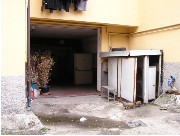
Ingresso al sub 707
