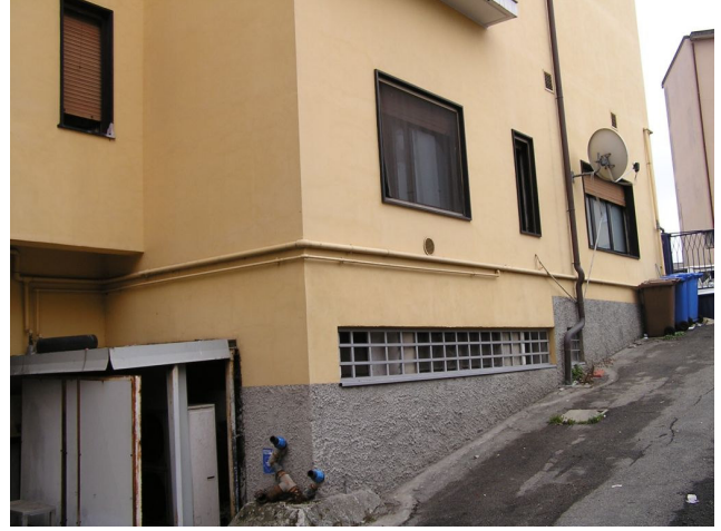
Rampa di accesso ai depositi ad uso esclusivo
