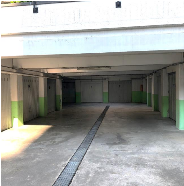
Vista corsello comune boxes mapp. 124, sub.10
