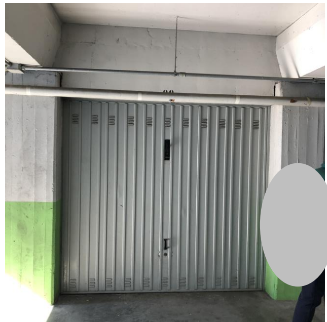
Vista serranda box mapp. 124, sub.10
