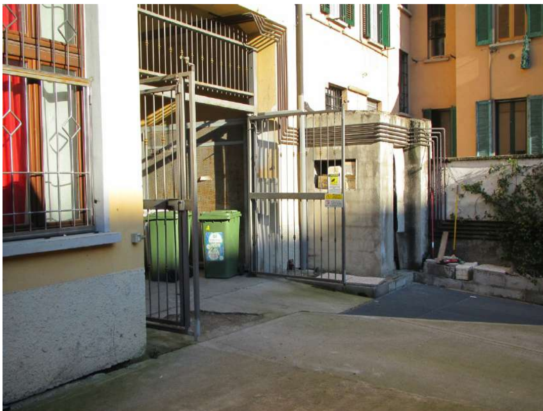
Cancello carraio e cortile posteriore (non facente parte del Condominio)
