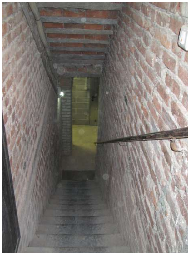
Scala di accesso alle cantine condominiali
