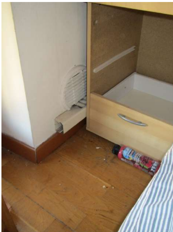
Dettagli – Foro di aerazione permanente con griglia
