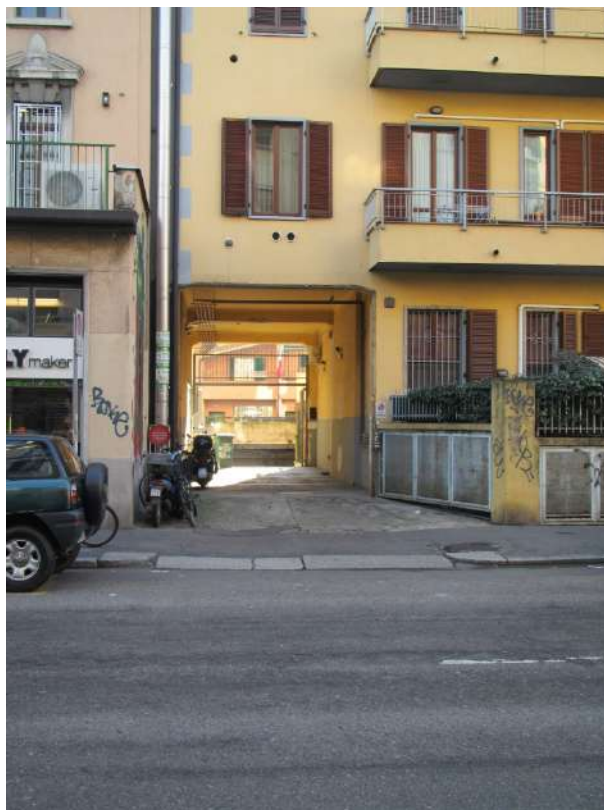
Ingresso pedonale e carraio dell'edificio
