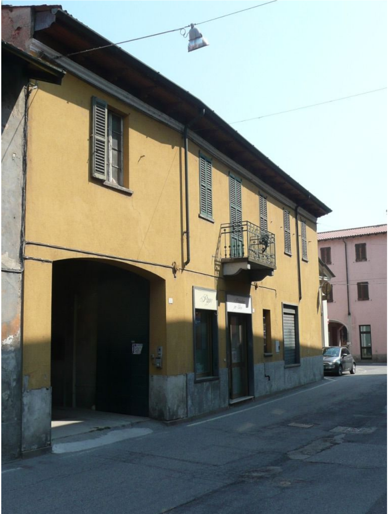
FACCIATA SU STRADA
