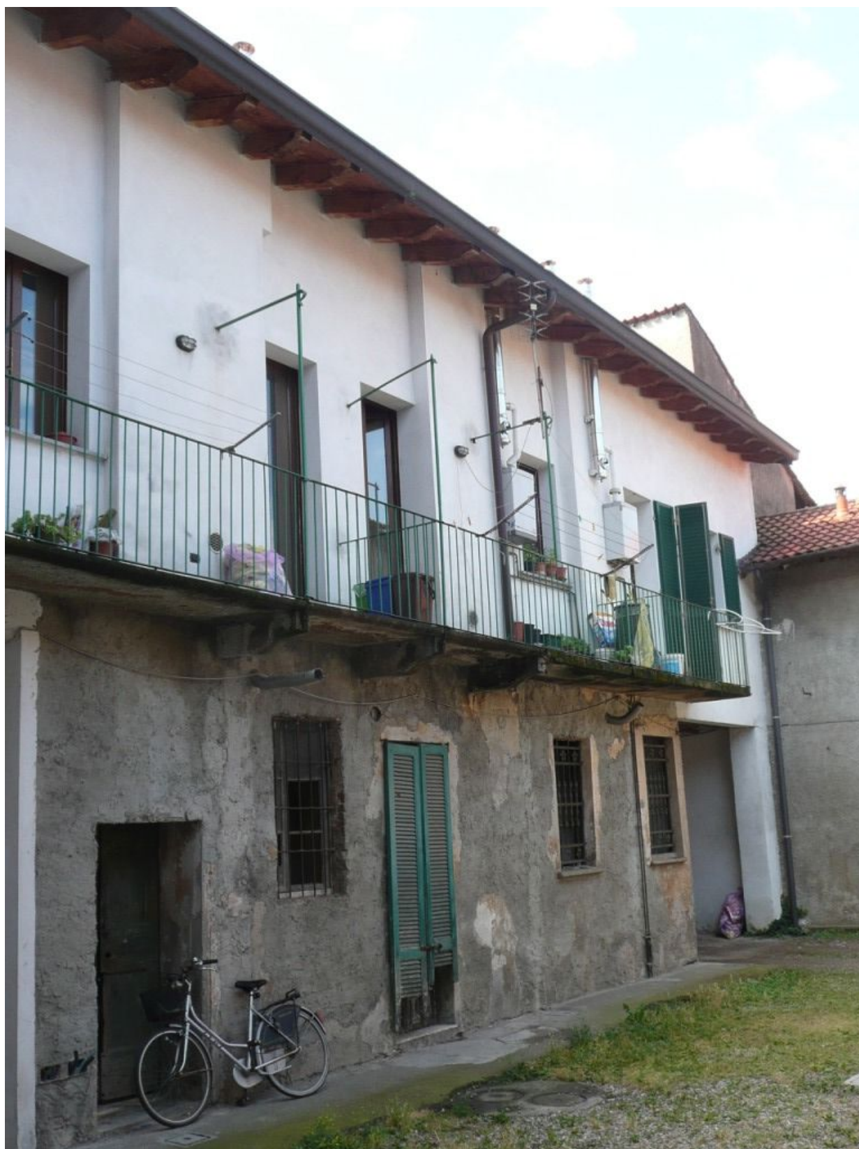
FACCIATA SU CORTILE POSTERIORE
