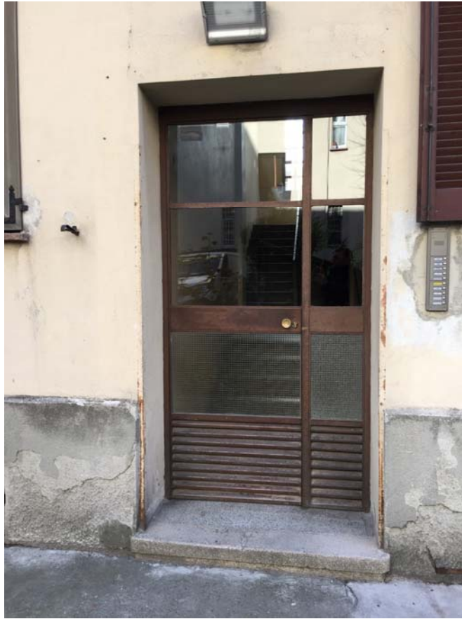
Foto 07 - Accesso al fabbricato alla scala G
