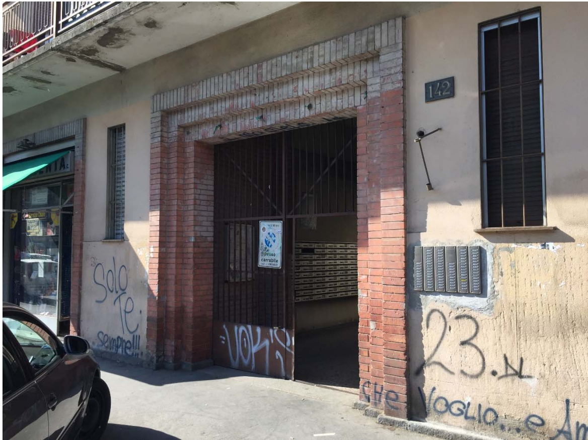
Foto 03 - Accesso al fabbricato al civico 142 di via Giambellino
