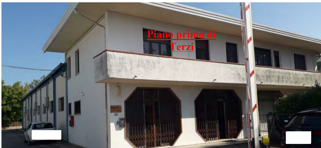
Porzione antistante con ingresso e parte destinata ad uffici
