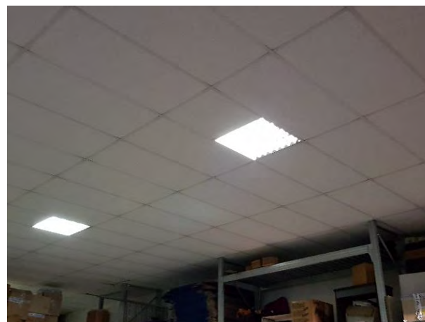
Particolare controsoffitto e illuminazione
