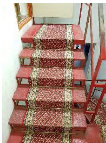
Scala in ferro per accesso al p.1
