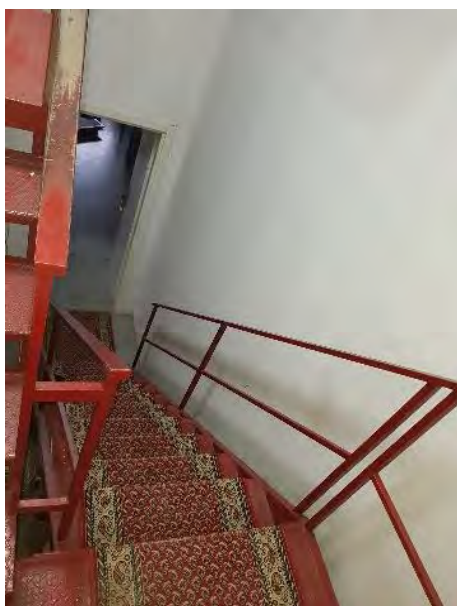
Scala in ferro per accesso al p.1
