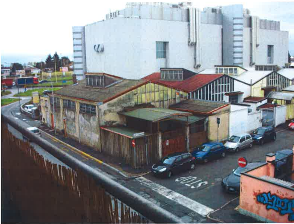
Vista da balcone – lato sud-est
