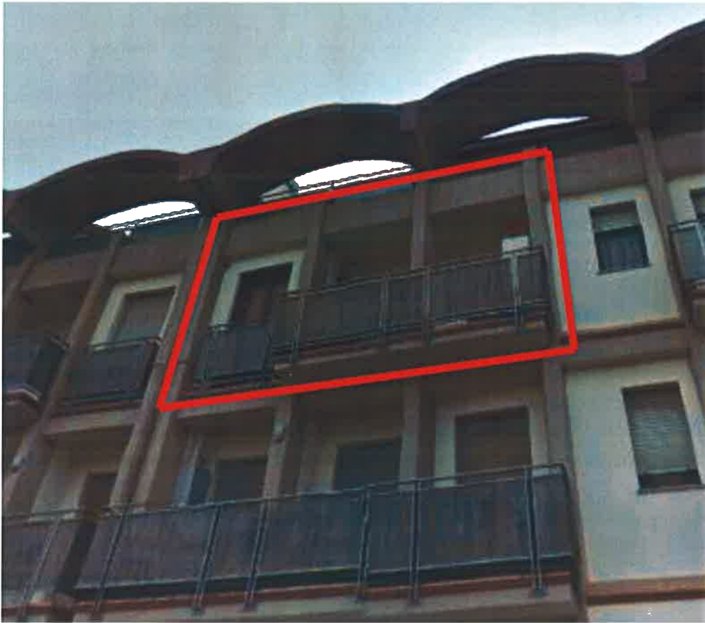
Facciata appartamento - via Marconi
