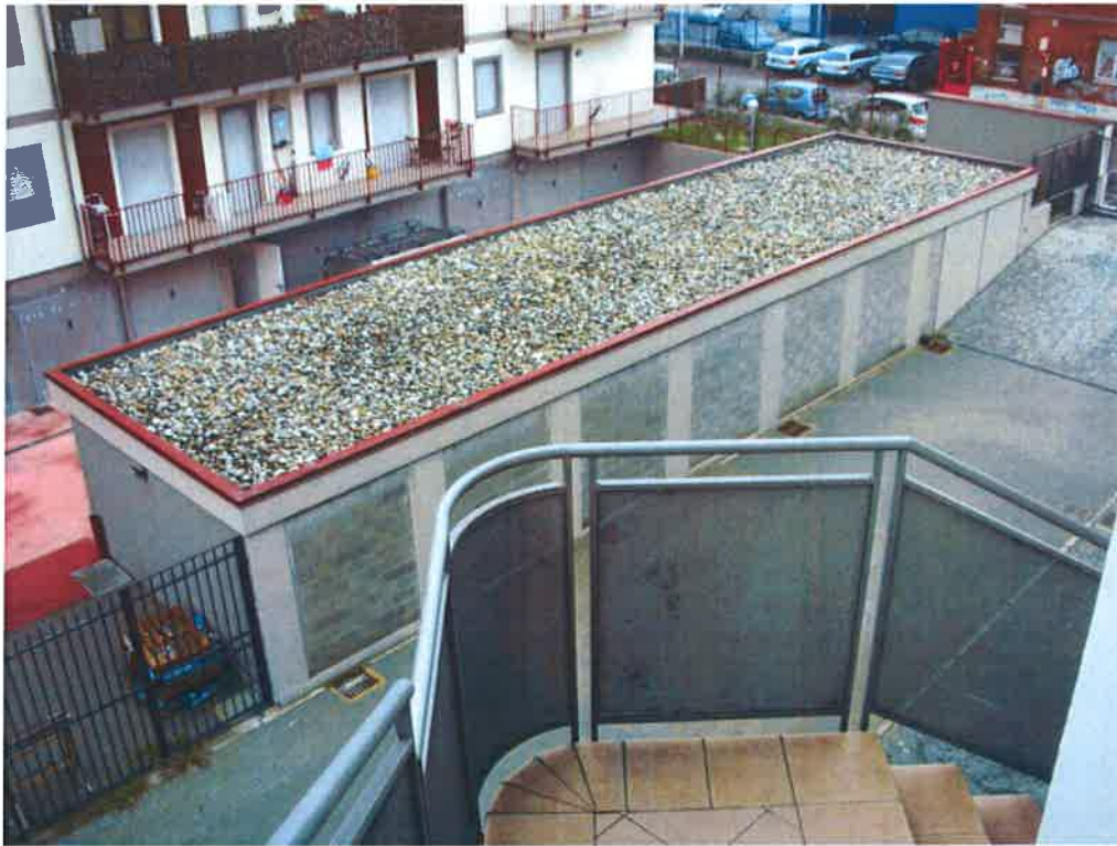
Vista frontale da vano scala
