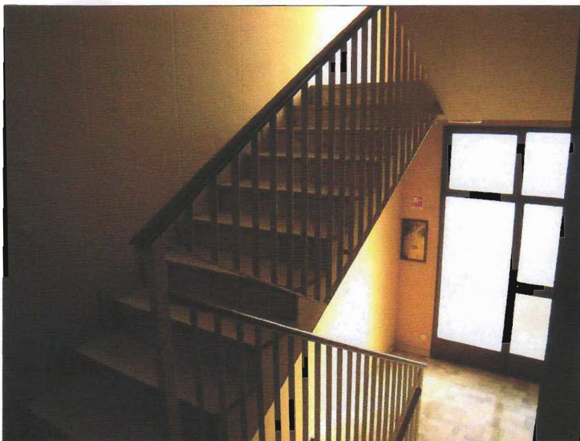
Foto 9 - Il vano scala "A".
