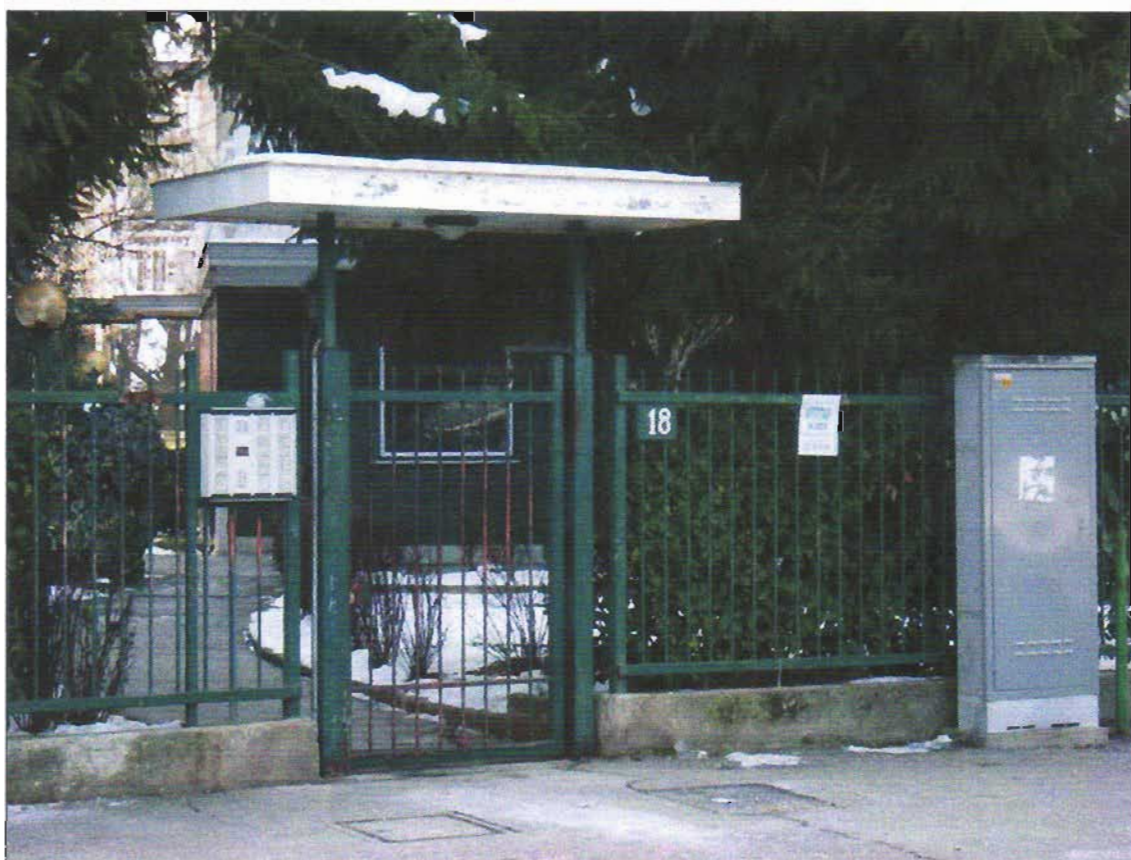
Foto 4 - Il cancello pedonale del civico 18.
