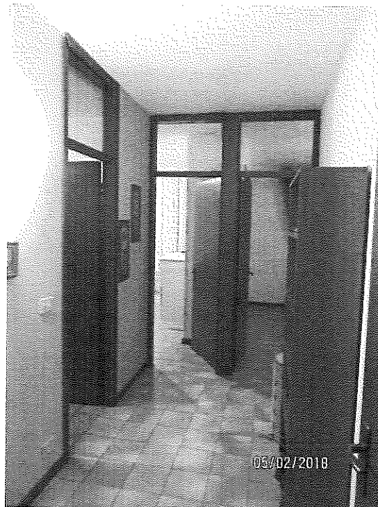
Foto 14 – Disimpegno zona notte
