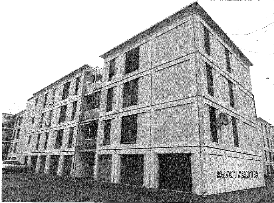
Foto 1 – Vista ed inquadramento, da via Filippo Turati, dell'unità immobiliare pignorata
