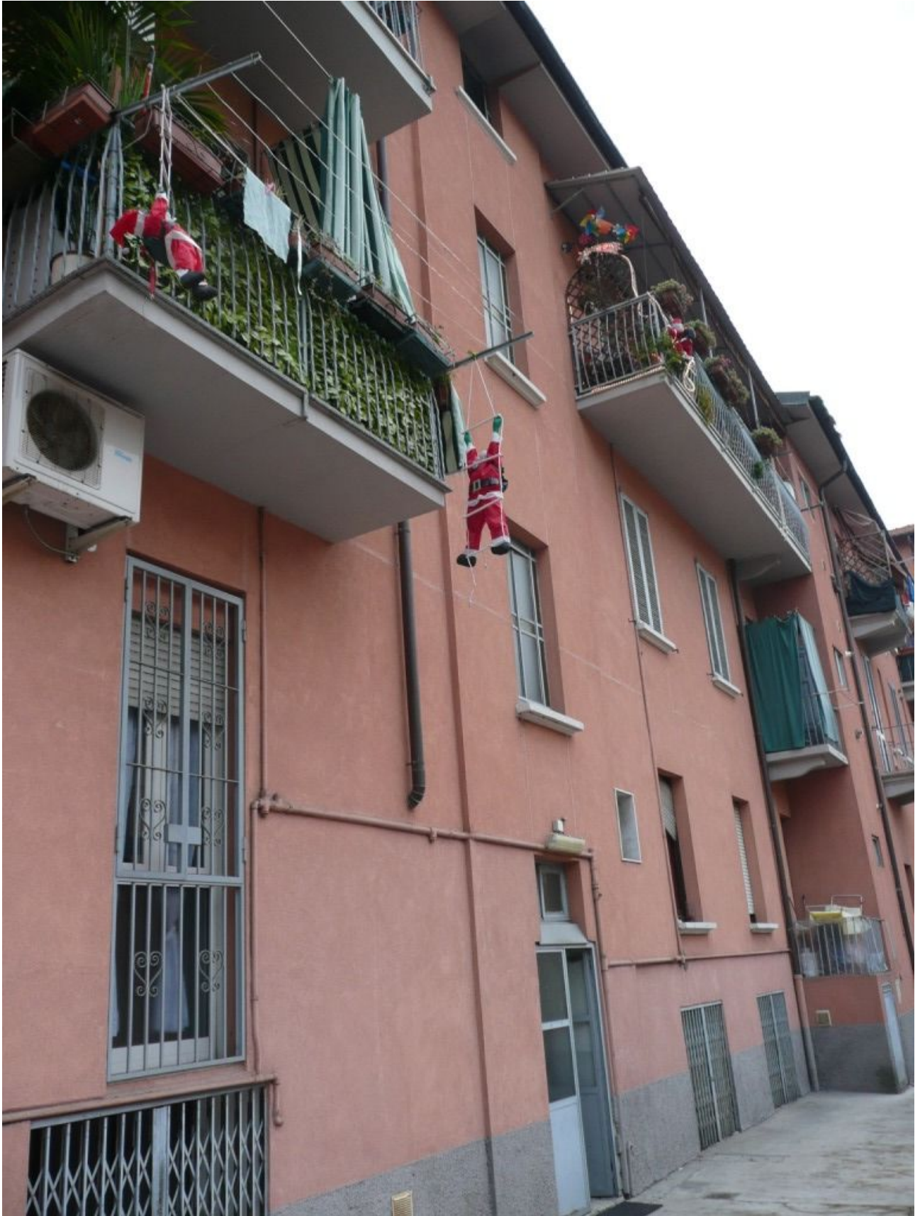
FACCIATA SU CORTILE INTERNO ED INGRESSO ALLA SCALA
