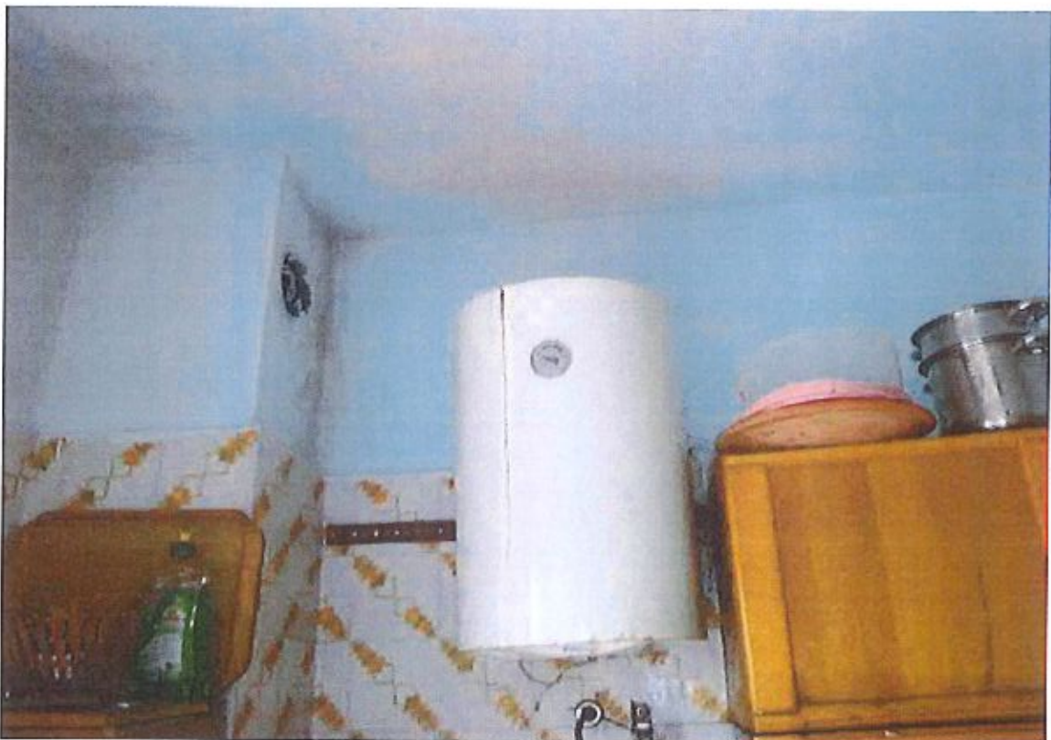
R.G.E. 1097/2017, G. E. Dott. Ssa M. G. Mennuni Pioltello, Via Cilea n.° 3, Scala M, piano 4°, Foglio 2, mapp. 589, sub. 17 Prospetti interni: il bagno e lo scaldabagno installato in cucina
