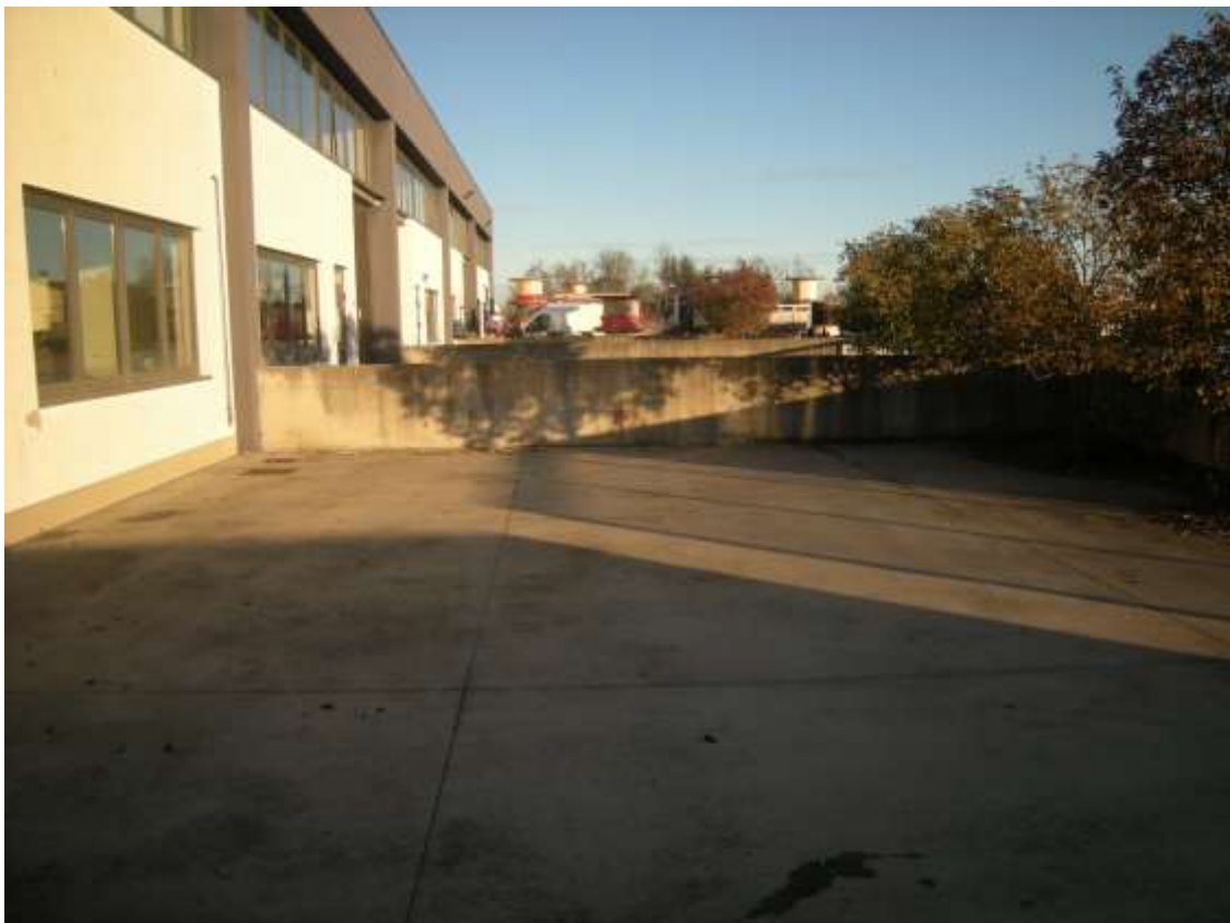
Concordia Sagittaria, foglio 5 particella 930, sub. 7 - Scoperto esclusivo.
