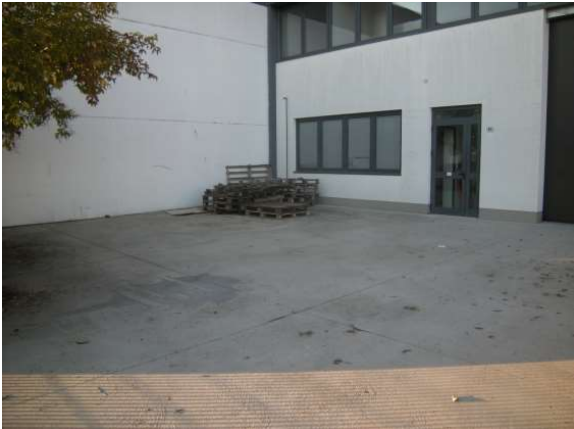
Concordia Sagittaria, foglio 5 particella 930, sub. 7 - Scoperto esclusivo.
