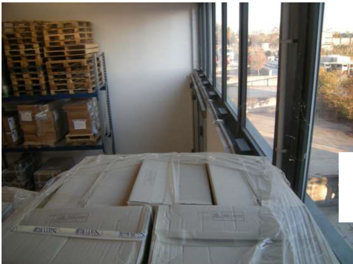
Concordia Sagittaria, foglio 5 particella 930, sub. 7 - Sopra particolare dell'impianto di riscaldamento, sotto gli infissi.
