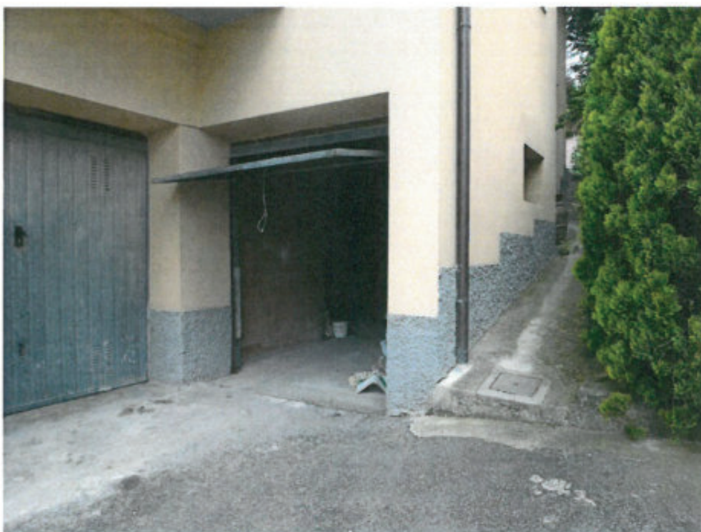
Foto n.3 - Ingresso del locale sub.2 p.la 251 al piano primo sottostrada
