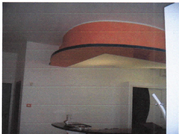
Ufficio P.T particolare controsoffitto
