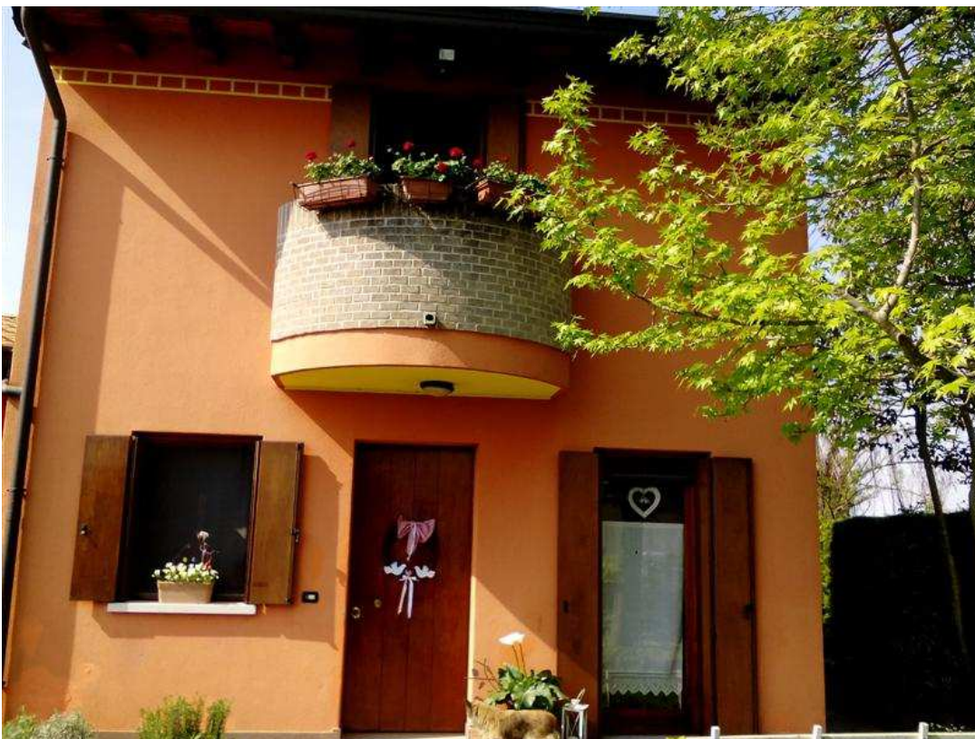
12) Fronte est abitazione
