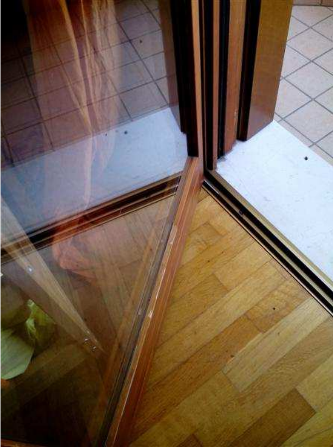
45) Particolari terrazzo camera 3)
