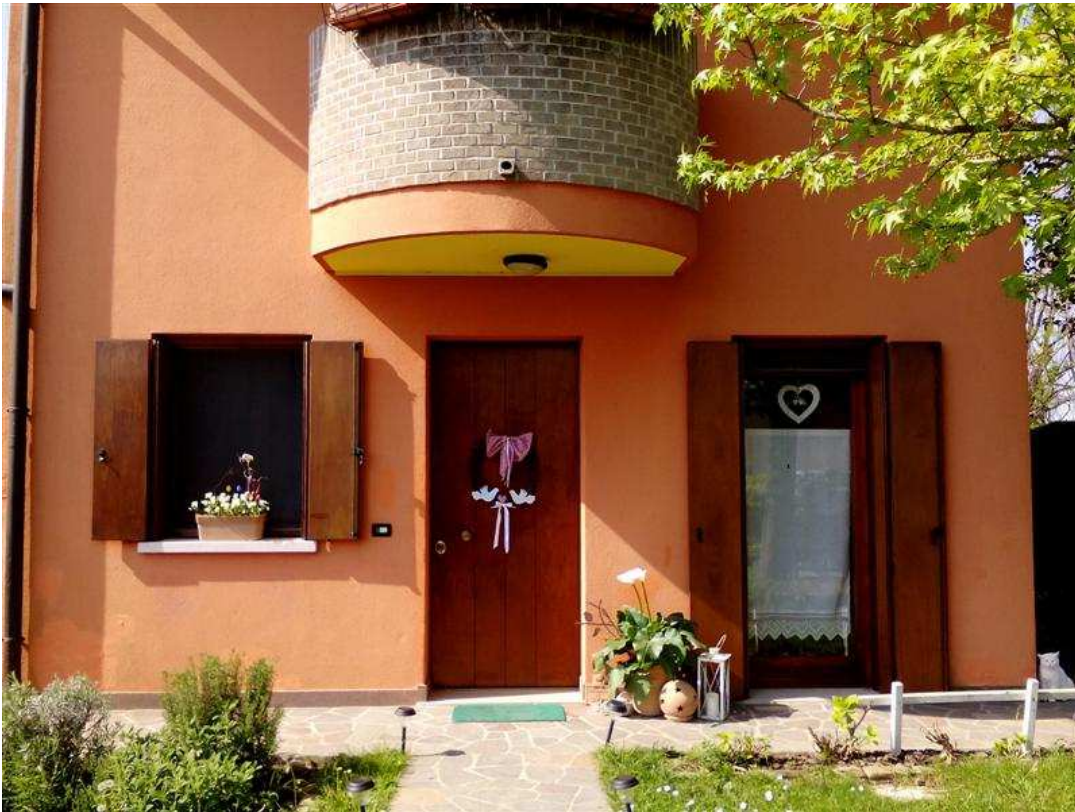
1) Ingresso all'abitazione dallo scoperto esclusivo
