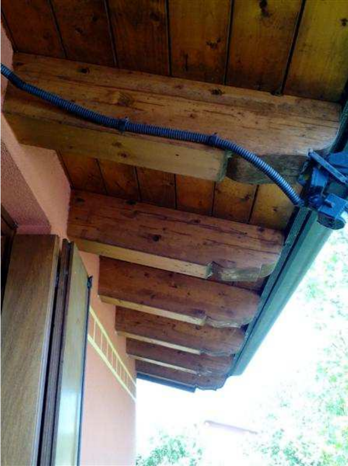
53) Particolari terrazzo camera 3)
