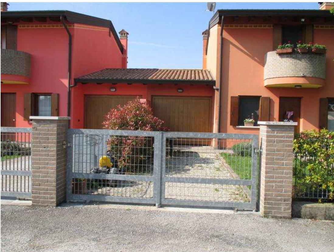
8) Particolare ingresso carrabile
