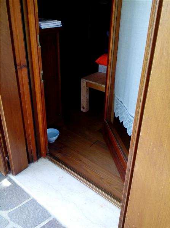
35) Particolari infissi soggiorno
