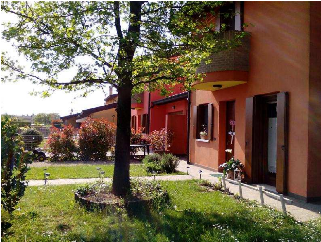
19) Veduta d'insieme del fronte est e della schiera a sud
