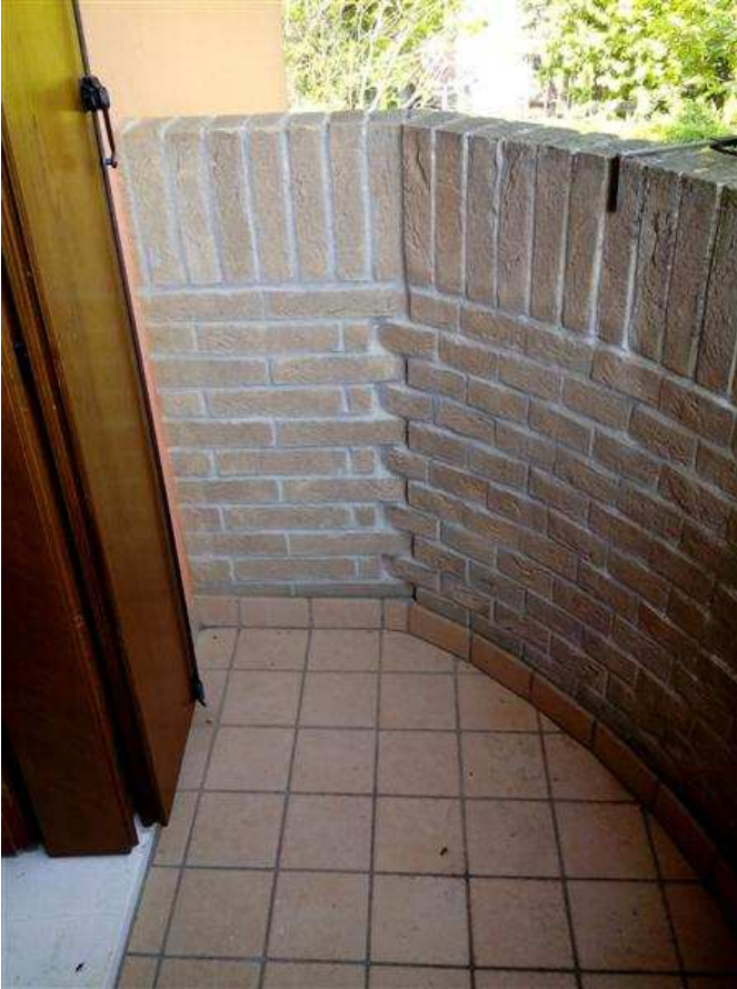
47) Particolari terrazzo camera 3)
