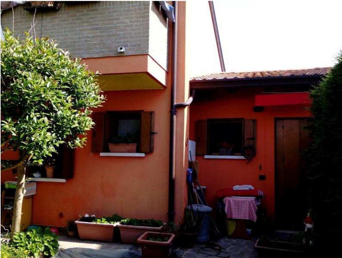
33) Fronte ovest abitazione (a sx) e garage (a dx)
