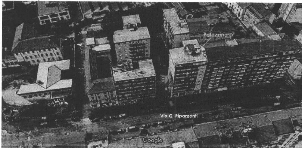
Foto satellitari. Complesso residenziale ubicato nel Comune di Milano, alla Via Ripamonti 194. Palazzina condominiale scala D
