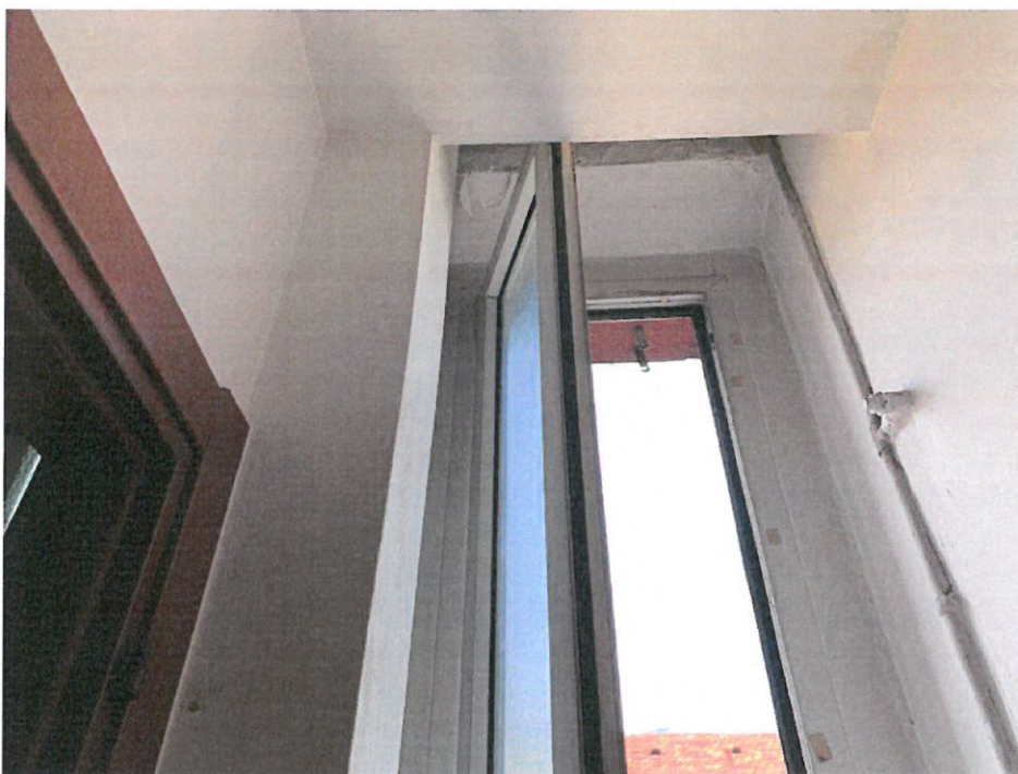
Fotografie n. 13/14 – Viste del corridoio aperto dotato di finestra e ribassato, dove sono presenti macchie di umidità, in assenza di percolamento di acqua, e dell'anta della finestra (sotto) che non si apre completamente
