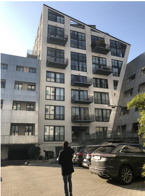
Foto 3. Il fabbricato inquadrato dal cortile.
