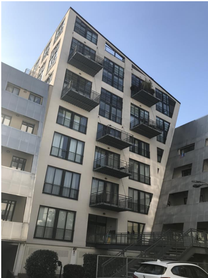
Foto 4. Il fabbricato inquadrato dal cortile. Dettaglio del corpo centrale.
