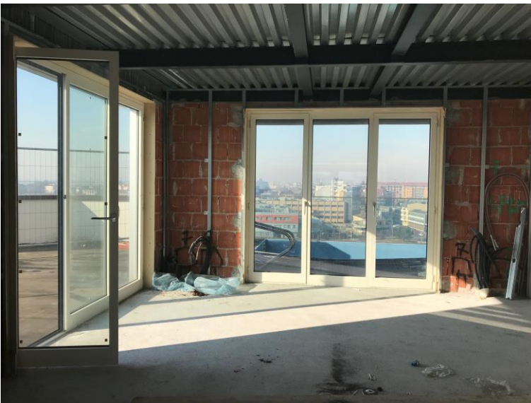
Foto 16 e immagine 4. Si nota che la faccia interna del paramento murario è al rustico senza che vi sia intonaco o controparete. Gli impianti sono predisposti. A lato una suggestione di come potrebbe essere lo spazio finito.
