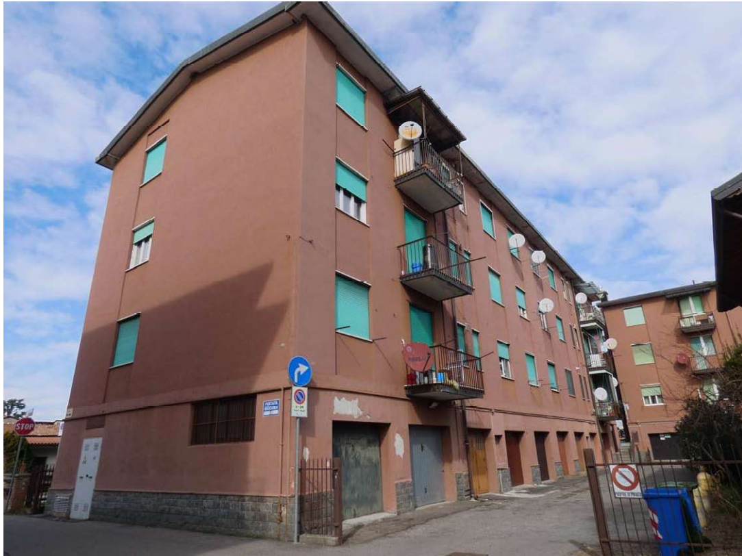
Foto 1: prospetto lato cortile e ingresso al civico 1A di Via Villorosi
