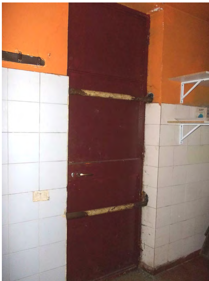
Porta di accesso fronte retro
