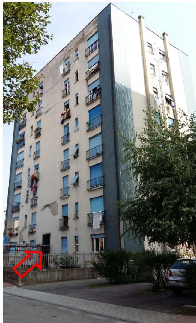
Vista fronte edificio da via Curiel
