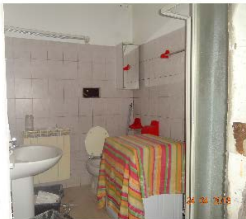
Vista interna - bagno/lavanderia
