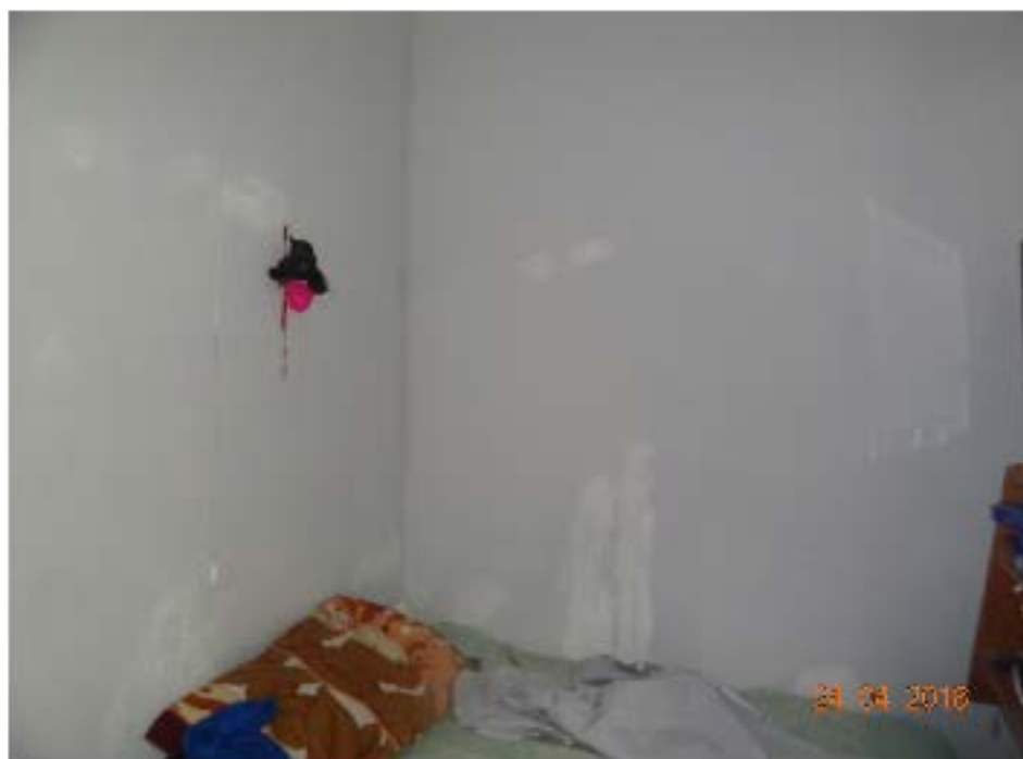
Vista interna - vano ricavato all'interno del piano terra
