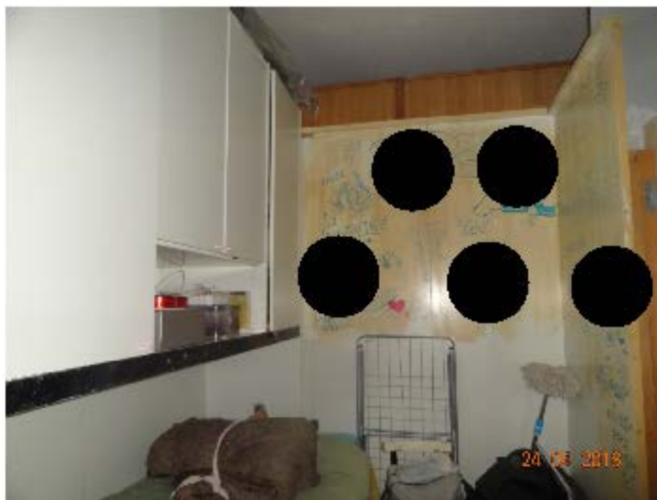
Vista interna - disimpegno piano seminterrato
