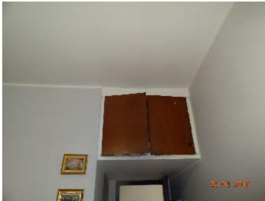
Vista interna - disimpegno
