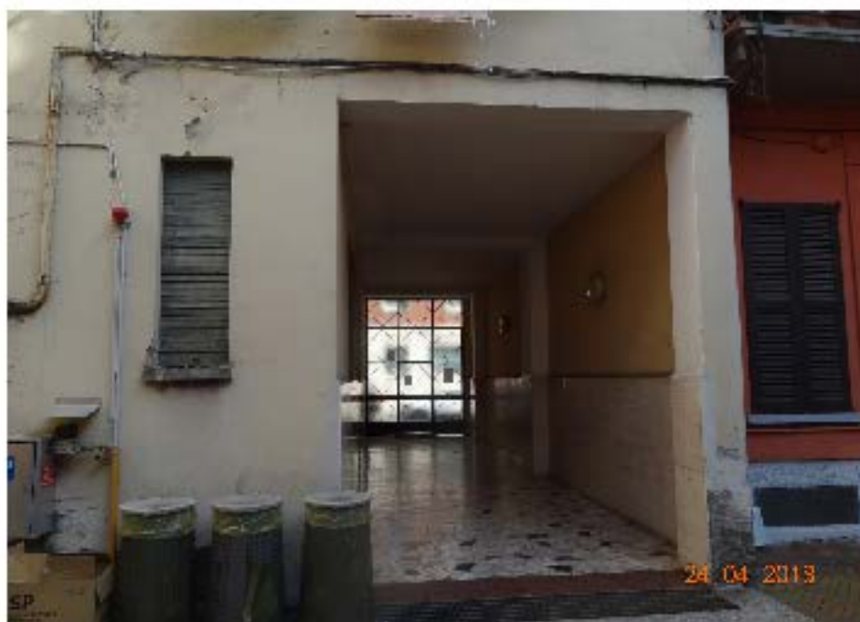
Vista esterna - ingresso condominio lato interno
