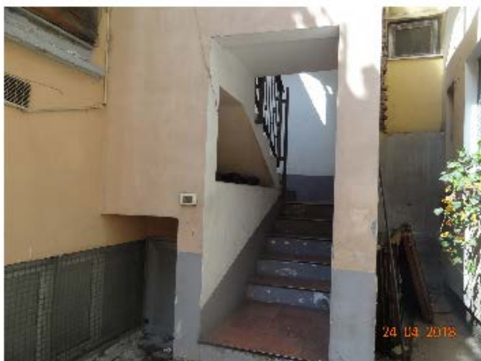
Vista esterna - ingresso comune lato cortile interno
