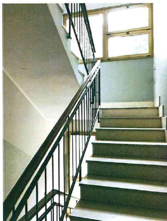
Vista vano scala comune
