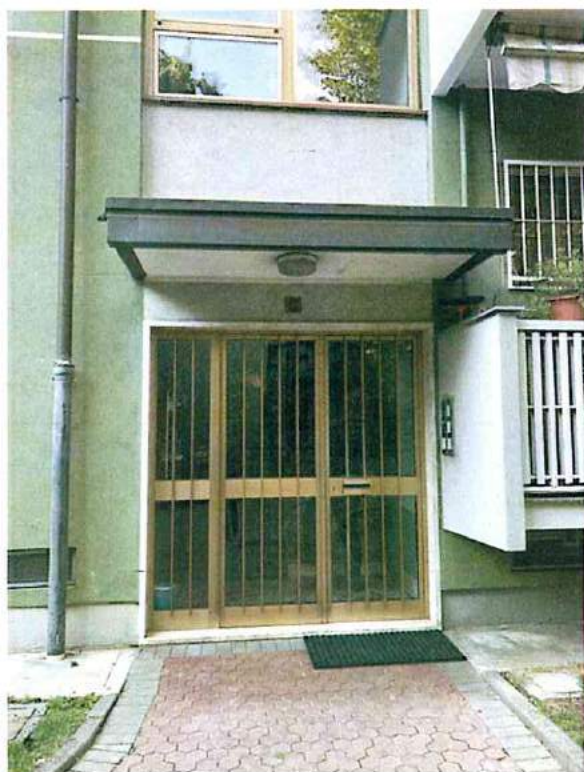
Vista portone di ingresso - scala C
