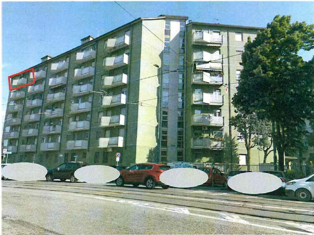
Vista del fabbricato da Viale Ungheria
