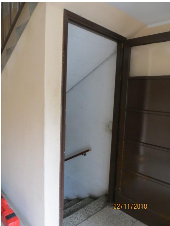
Foto 18 – Porta al piano terra di accesso al piano cantine
