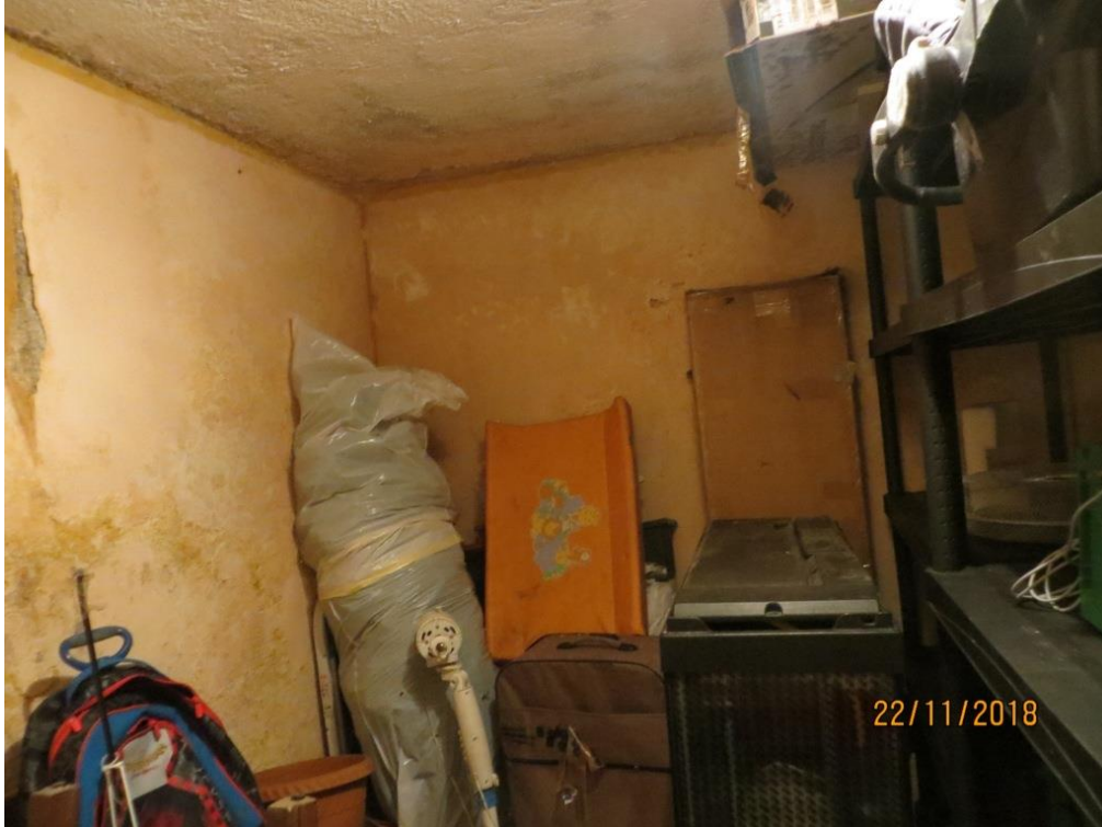
Foto 20 - Vista della cantina annessa all'appartamento
