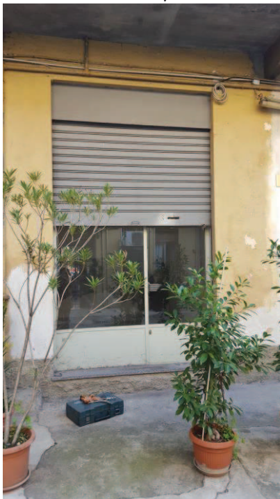
INGRESSO EX SUB 29
