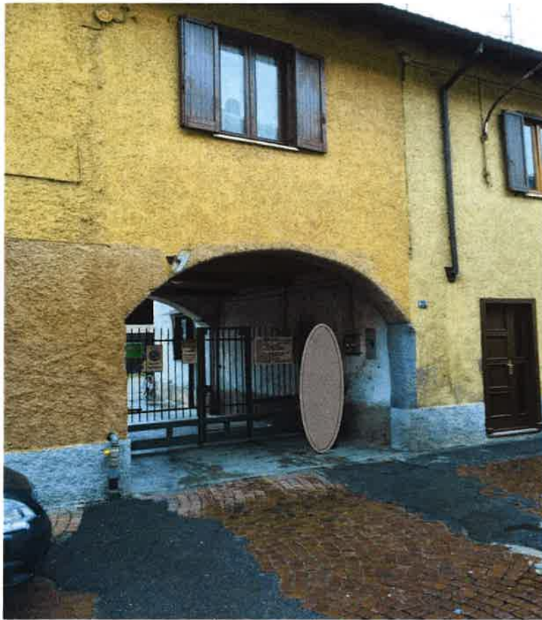
Viste accesso su via Cavour 7
