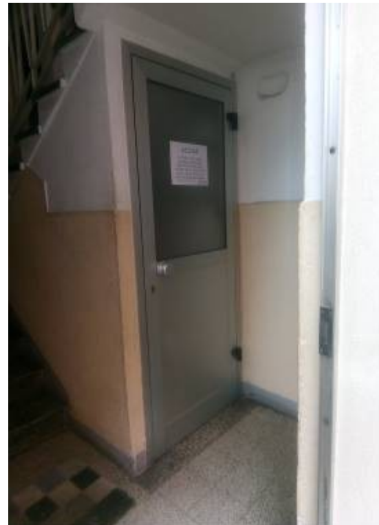
accesso condominiale alle cantine
