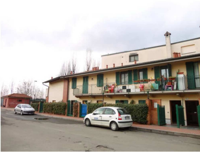
Vista del prospetto su via Baroni
