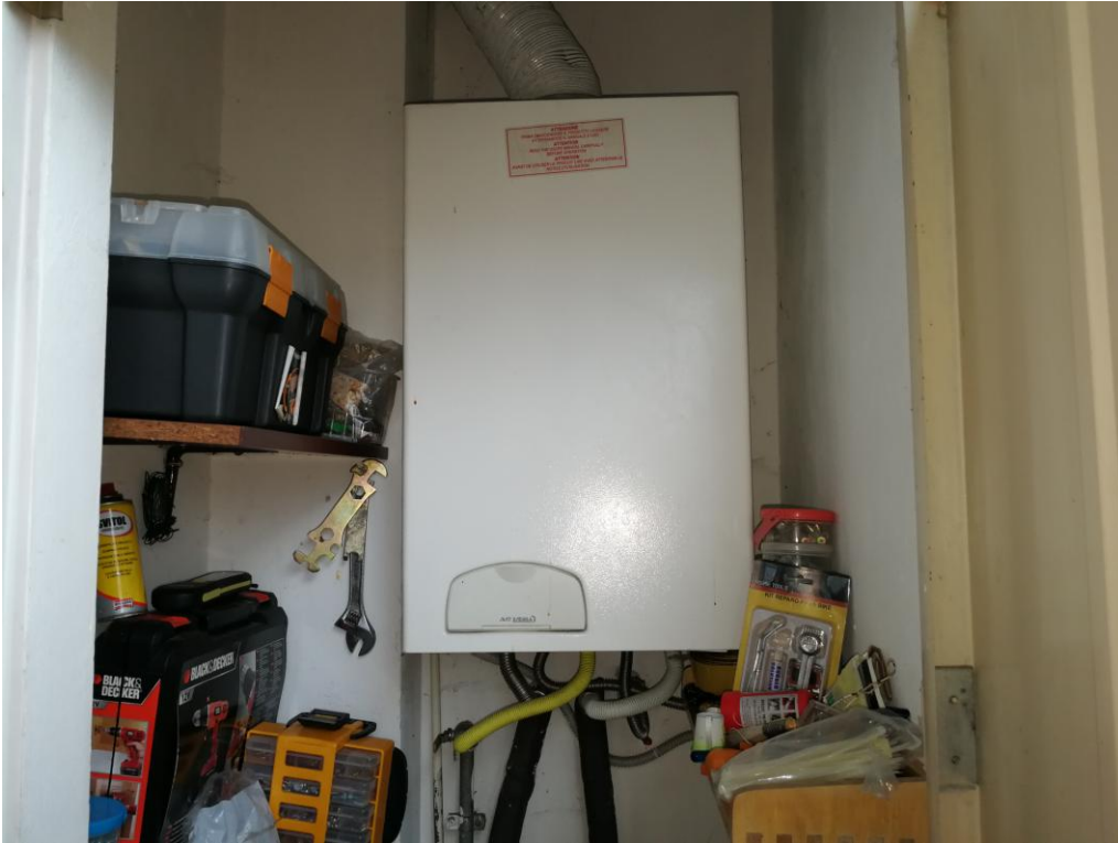
FOTO N.15 FOGLIO 7, SEZ. A, MAPPALE 80, SUB.7 COMUNE DI GODEGA DI S.U. (TV)
