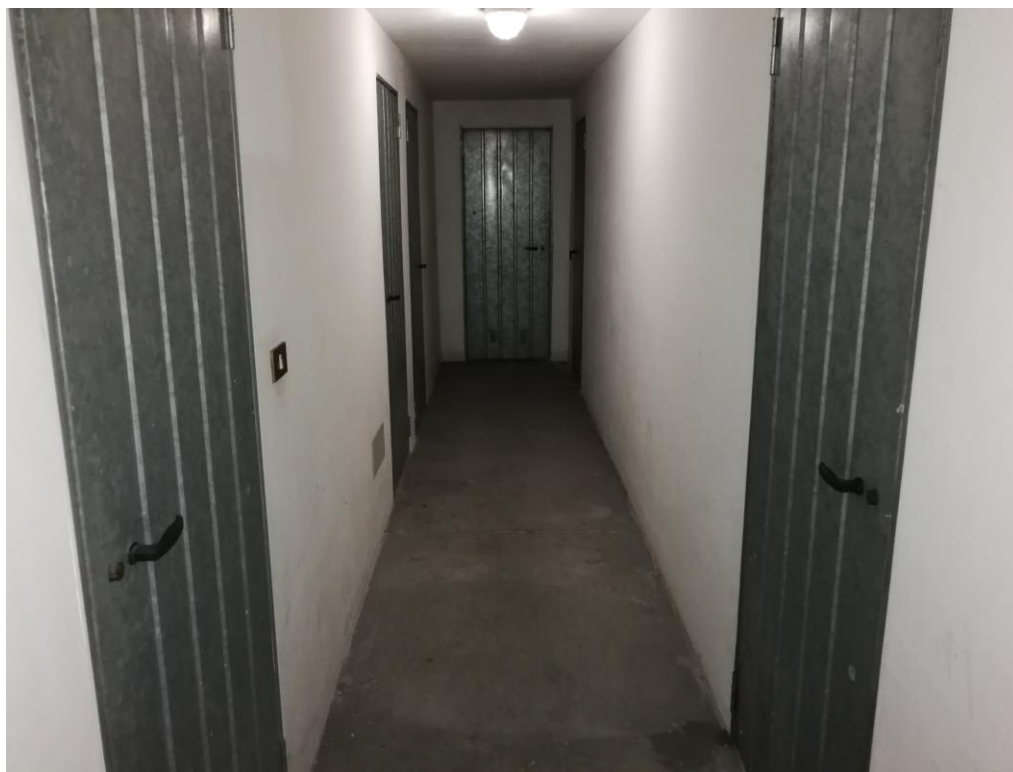
FOTO N.19 FOGLIO 7, SEZ. A, MAPPALE 80, SUB.13 COMUNE DI GODEGA DI S.U. (TV)
