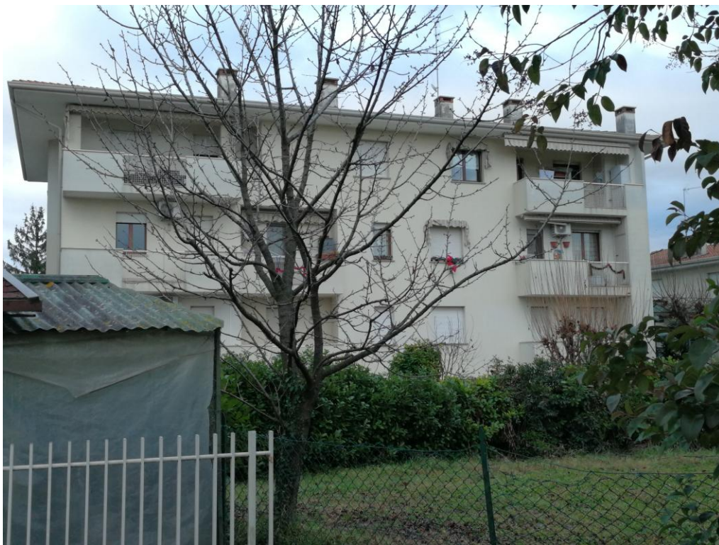
FOTO N.03 FOGLIO 7, SEZ. A, MAPPALE 80, SUB.7 COMUNE DI GODEGA DI S.U. (TV)
