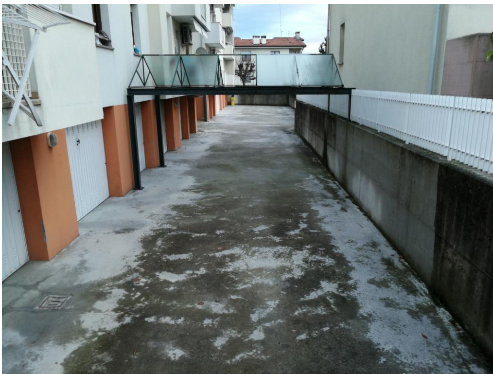
FOTO N.04 FOGLIO 7, SEZ. A, MAPPALE 80, SUB.7 COMUNE DI GODEGA DI S.U. (TV)
