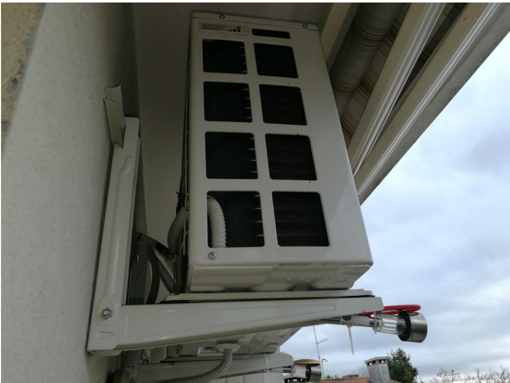
FOTO N.16 FOGLIO 7, SEZ. A, MAPPALE 80, SUB.7 COMUNE DI GODEGA DI S.U. (TV)
