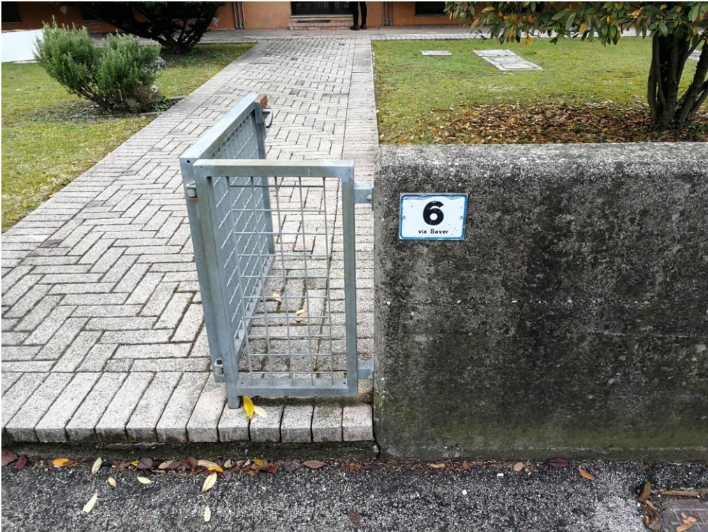
FOTO N.05 FOGLIO 7, SEZ. A, MAPPALE 80, SUB.7 COMUNE DI GODEGA DI S.U. (TV)
