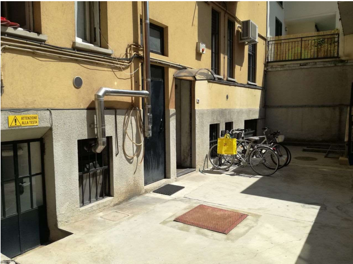
Porta di ingresso all'immobile sotto la pensilina
