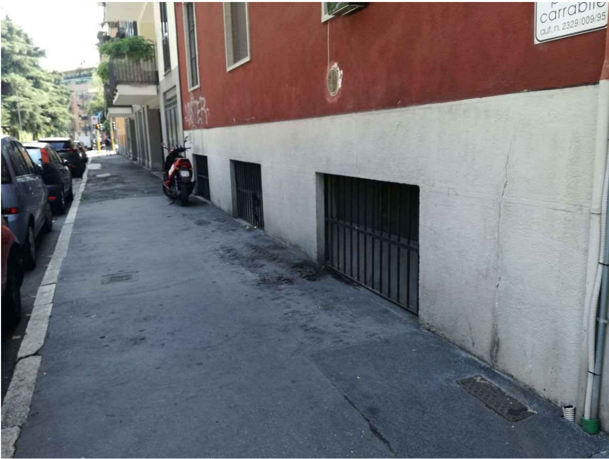
Finestre dell'immobile da lato stradale Prineti
