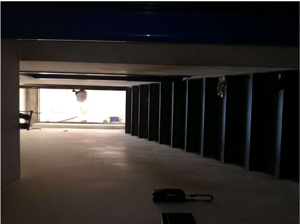
Porta di ingresso vista da base scala
