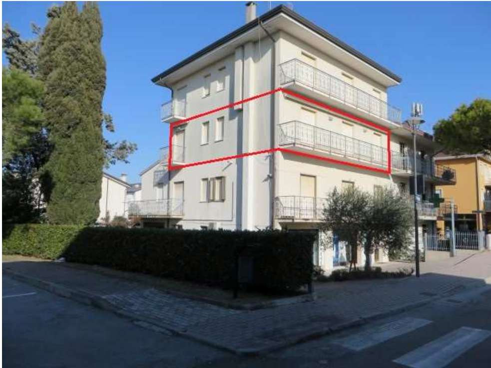
FOTO 43: APPARTAMENTO IN EVIDENZA AL SECONDO PIANO
