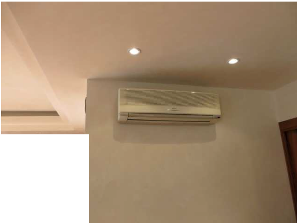
FOTO 58: UNITA' INTERNA DEL CLIMATIZZATORE (Secondo Piano)
