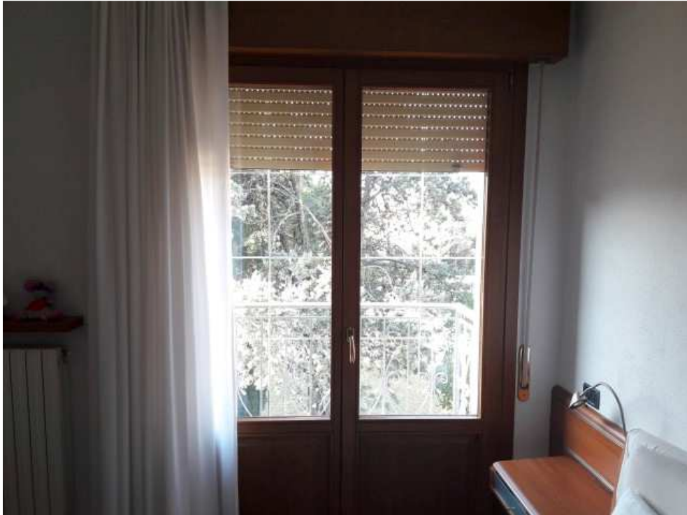
FOTO 55: PARTICOLARE SERRAMENTO (Secondo Piano)
