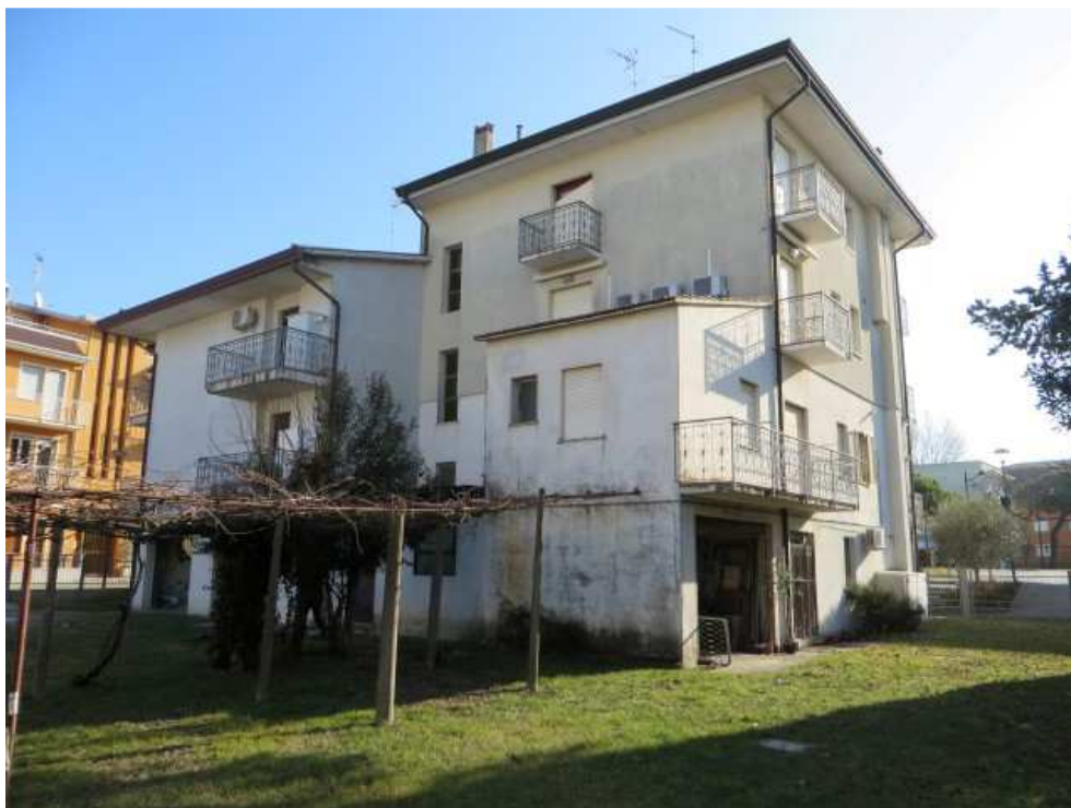
FOTO 36: PANORAMICA DAL MAPP. 940 E CORTE INTERNA
