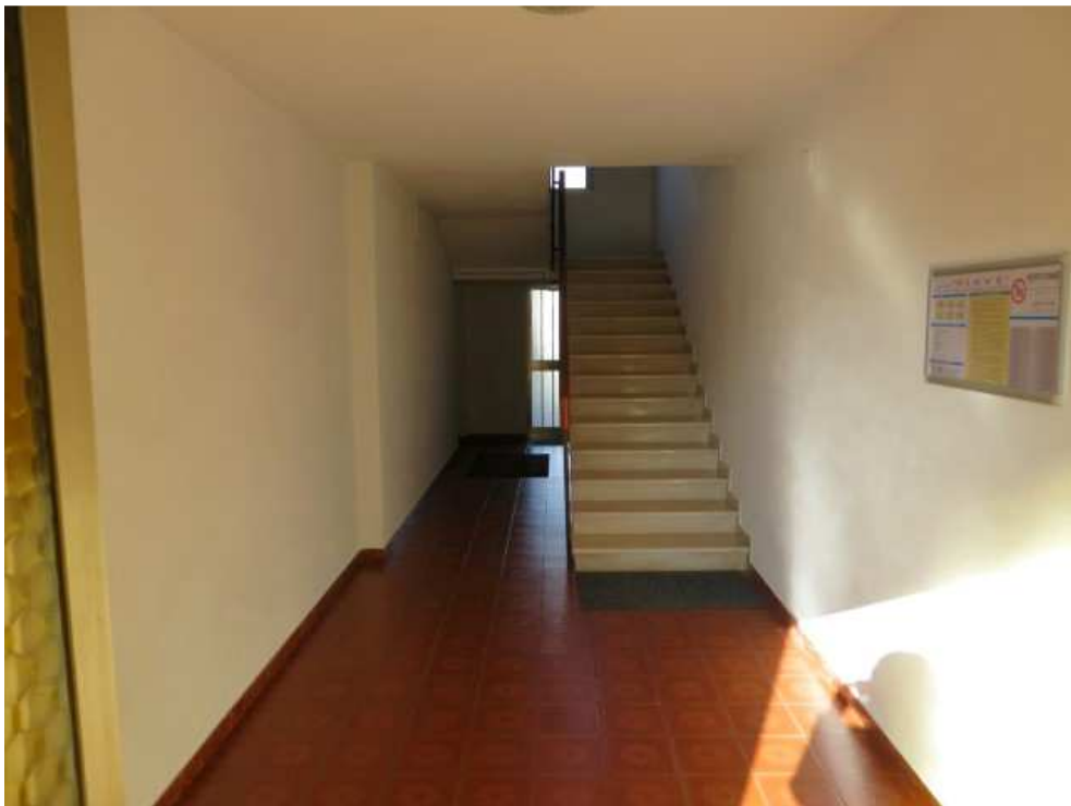
FOTO 42: VANO SCALE CONDOMINIALE (Piano Terra)
