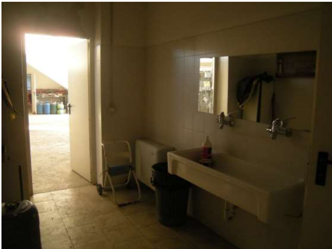
Concordia Sagittaria, foglio 5 particella 930, sub. 11, piano terra - I locali wc e l'anti bagno.
