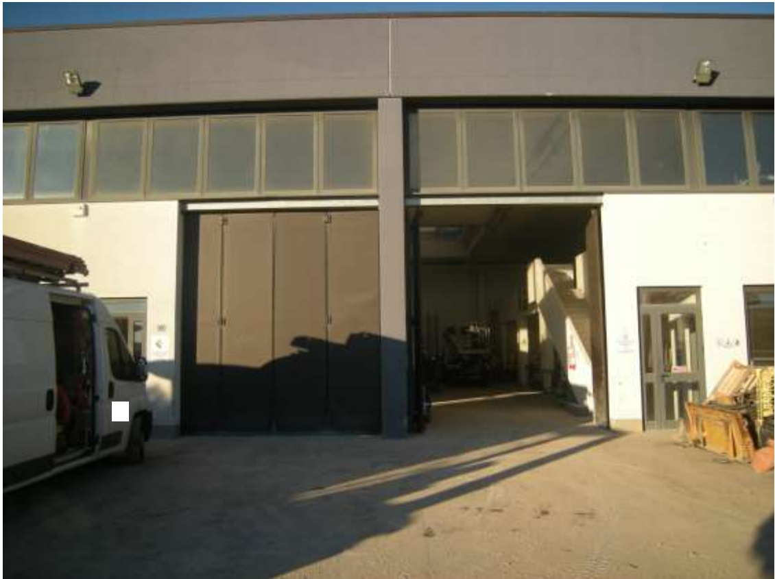
Concordia Sagittaria, foglio 5 particella 930, sub. 11 - Scoperto esclusivo.
