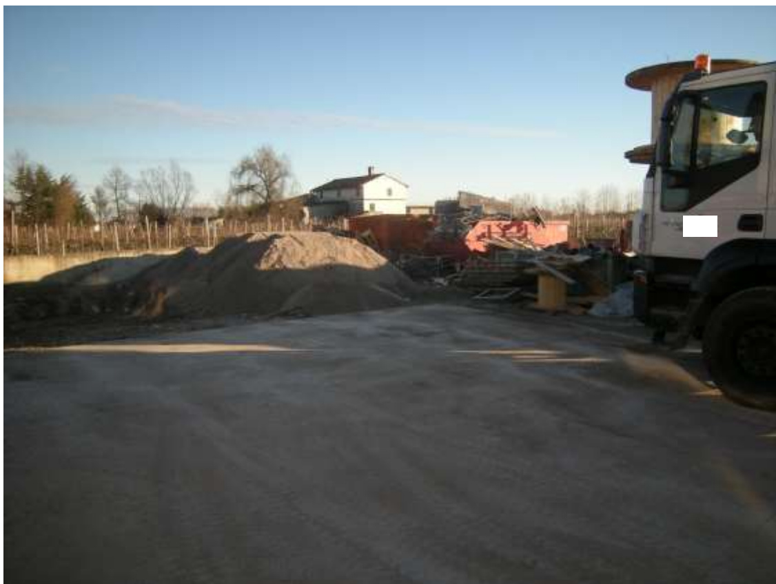
Concordia Sagittaria, foglio 5 particella 930, sub. 11 - Scoperto esclusivo.
