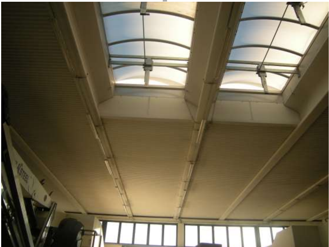
Concordia Sagittaria, foglio 5 particella 930, sub. 11 - L'interno del capannone.
