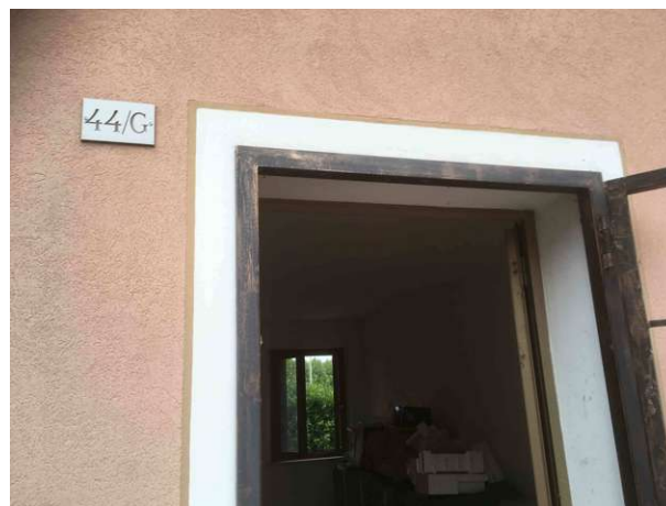
Veduta esterna accesso
