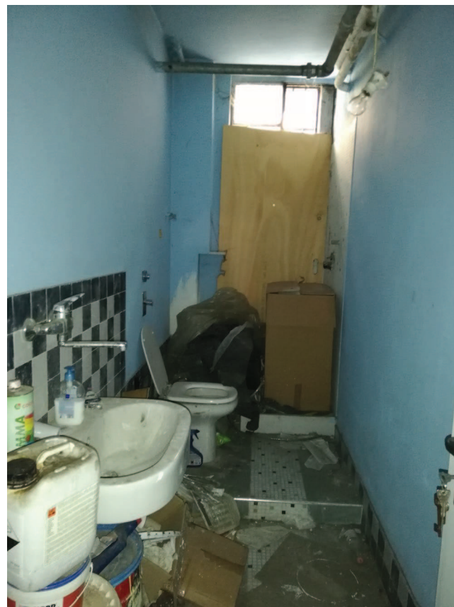
Vista della cantina e del bagno al piano interrato
