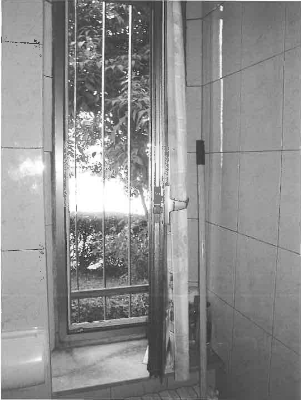
FOTO 12 – Dettaglio del serramento in alluminio del bagno
