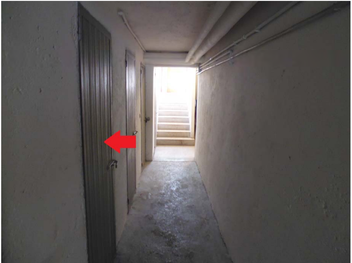
Foto 20 – accesso alla cantina
