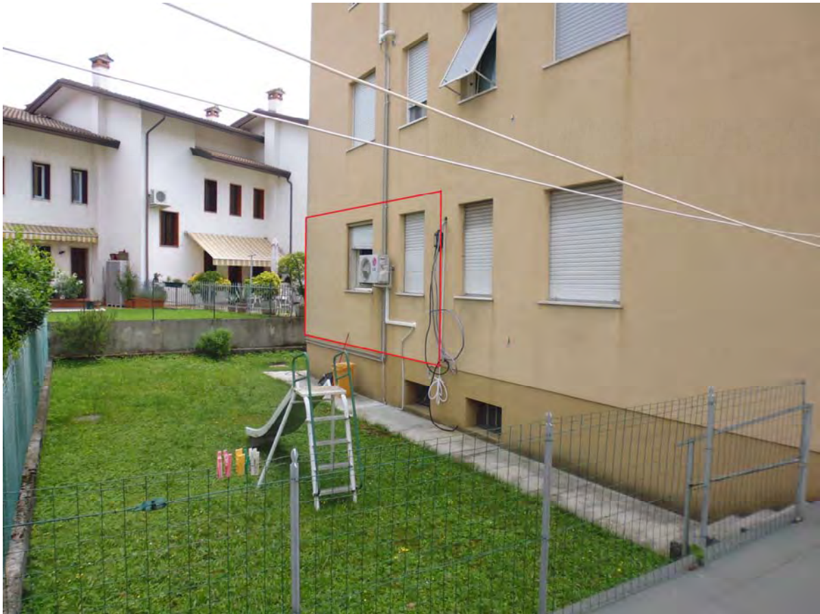
Foto 2 – vista retro lato Nord con individuata l’unità immobiliare
