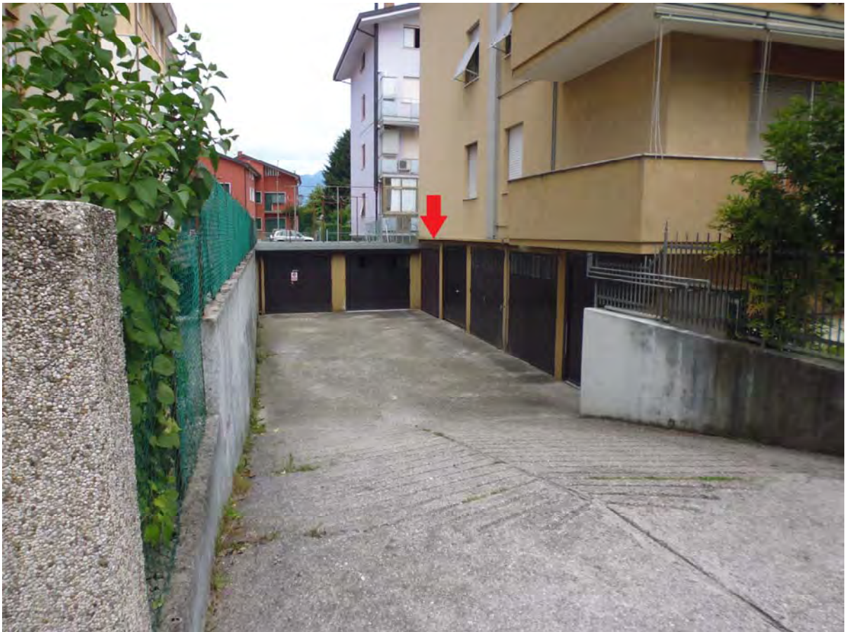
Foto 22 – accesso al garage
