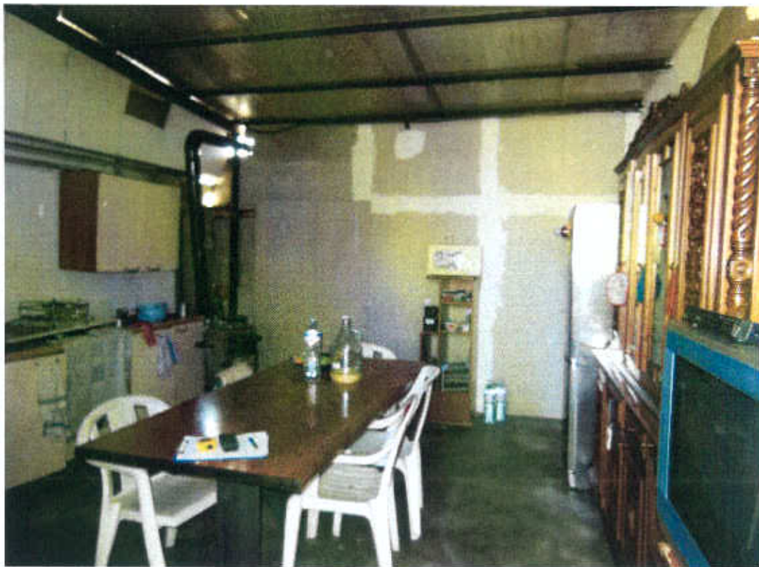
Foto 14: porzione di tettoia adibita a cucina
