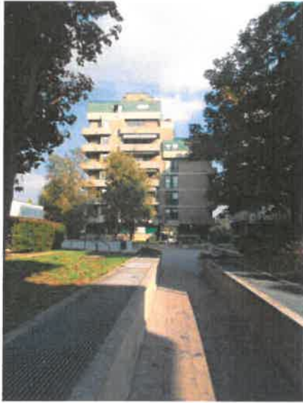
7. Vialetto di ingresso allo stabile
