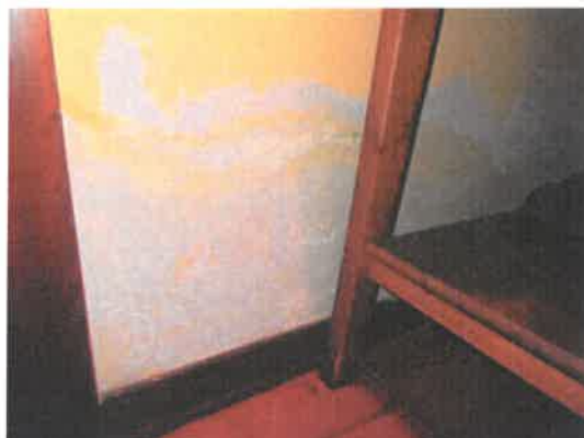
34. Dettaglio muro interno
