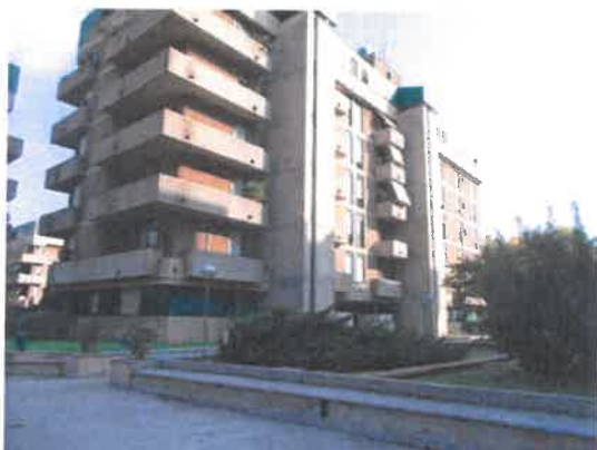
3. Un fabbricato tipo del complesso
