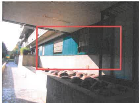
10. Esterno dell'immobile pignorato
