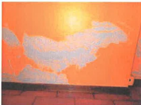
33. Dettaglio muro interno
