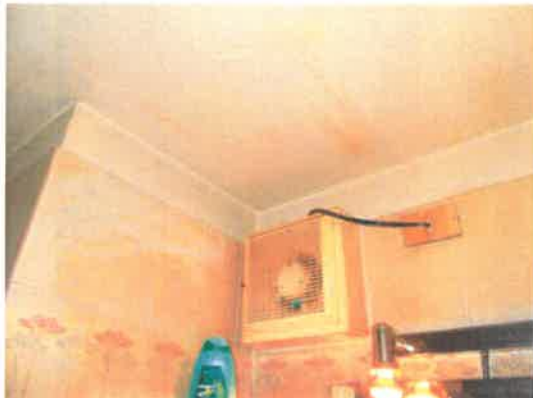
31. Soffitto del bagno
