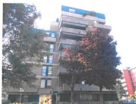
6. Fabbricato all'interno del quale si trova l'immobile oggetto di pignoramento
