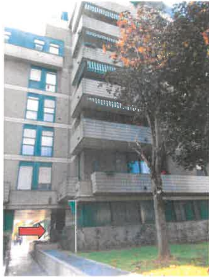
8. Vialetto di ingresso allo stabile
