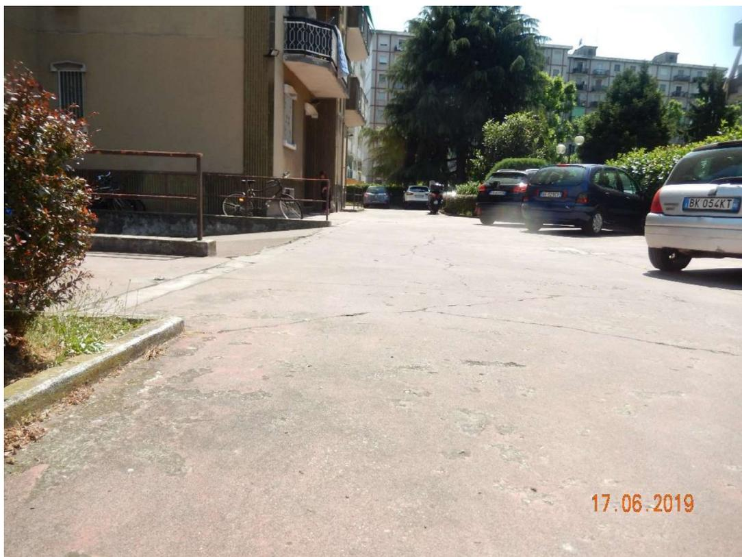
8) Edificio. A sinistra facciate lato rampa boxes, a destra facciata lato via Garofani. Visibili la zona prevalente ad intonaco plastico, gli spigoli verticali e lo zoccolo a cortile a clinker.
