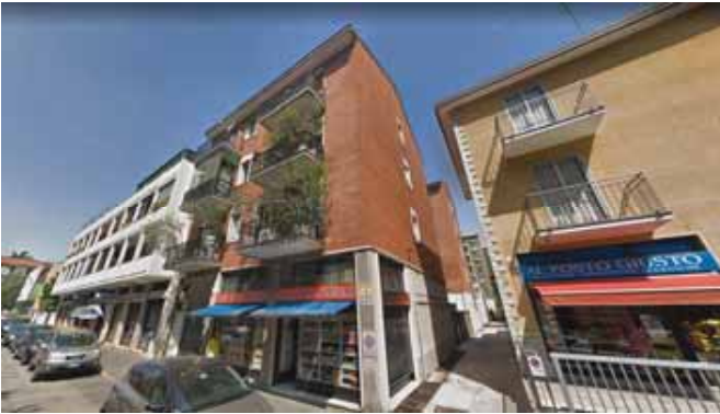
Condominio corpo su strada
