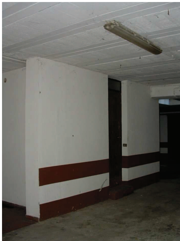
Piano interrato – Porta di ingresso del locale comune che da accesso al servizio di pertinenza del negozio
