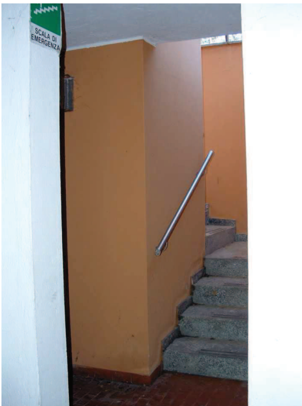
Piano interrato - Scala di accesso
