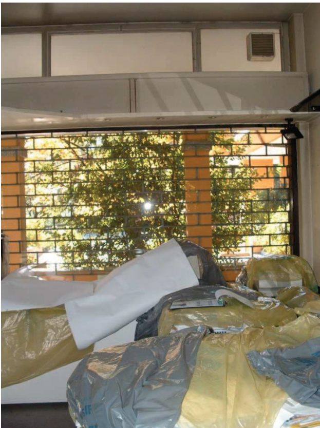
Vista dall'interno verso l'altro lato della vetrina
