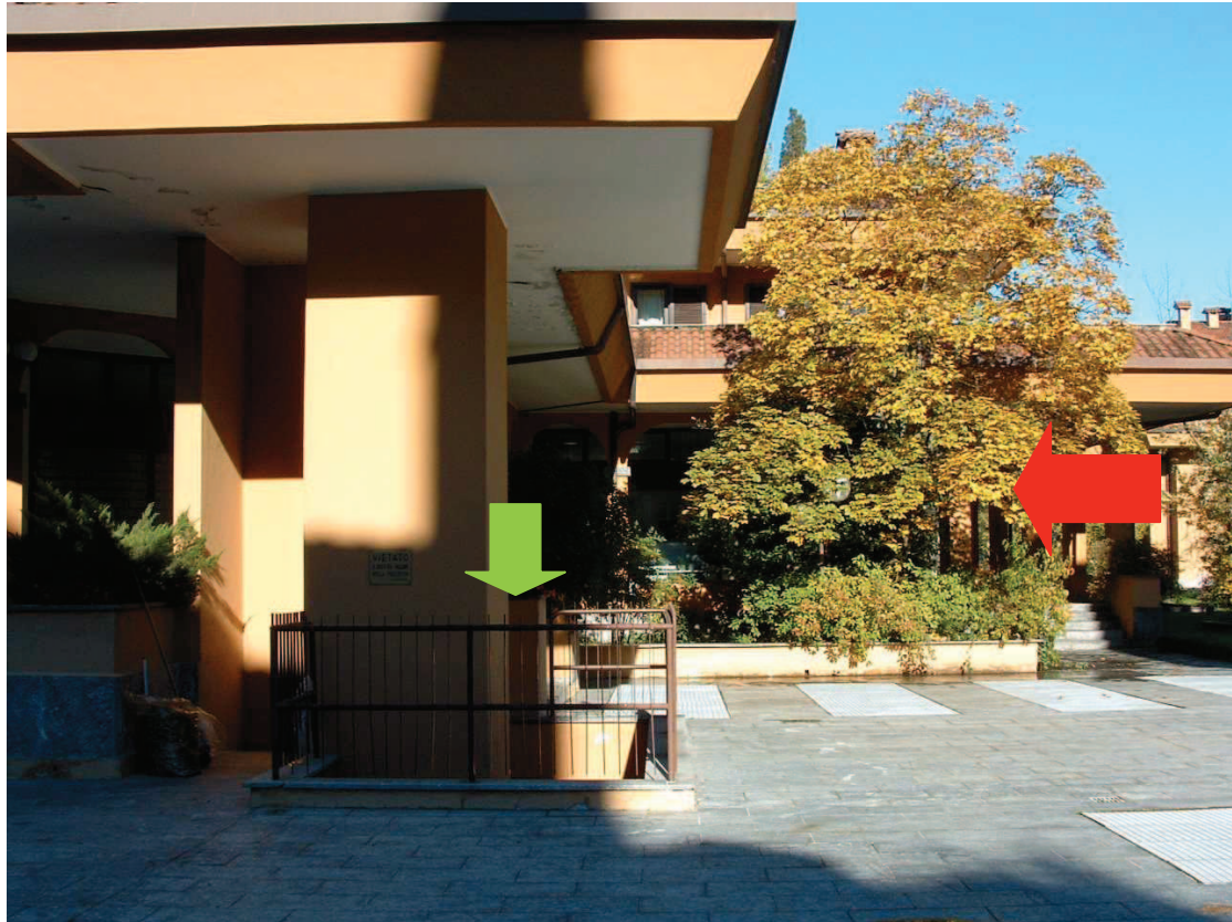
Vista del vano scale (freccia verde) da utilizzare per accedere al piano interrato ed al locale di servizio di pertinenza del negozio (indicato con la freccia rossa)
