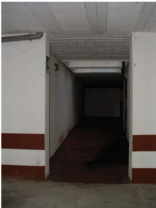
Piano interrato – Corridoio visto dallo spazio carrabile
