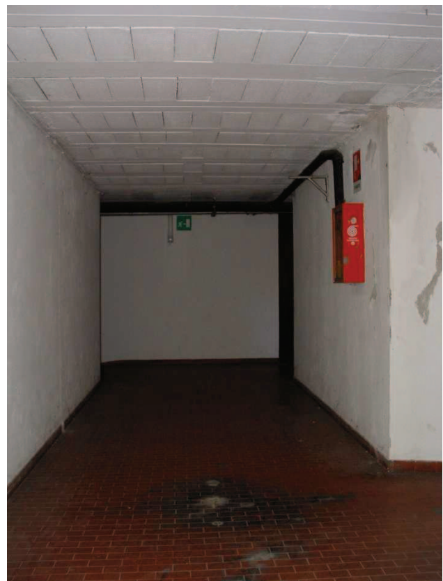
Corridoio verso gli spazi carrabili
