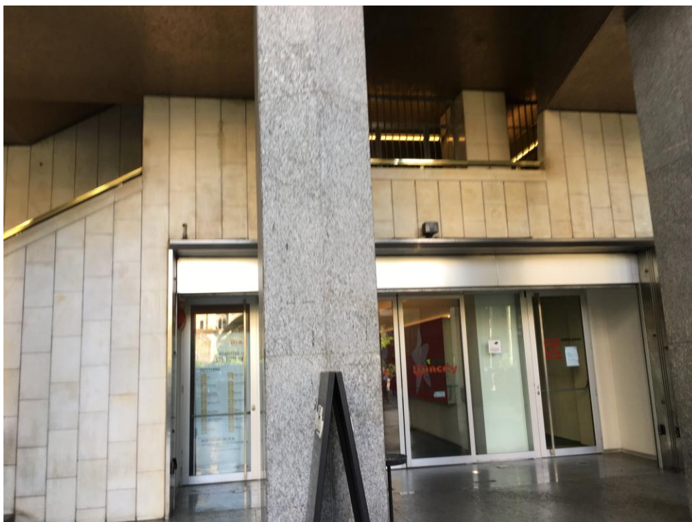
FOTO 1: MILANO, PIAZZA DIAZ 7, ingresso
