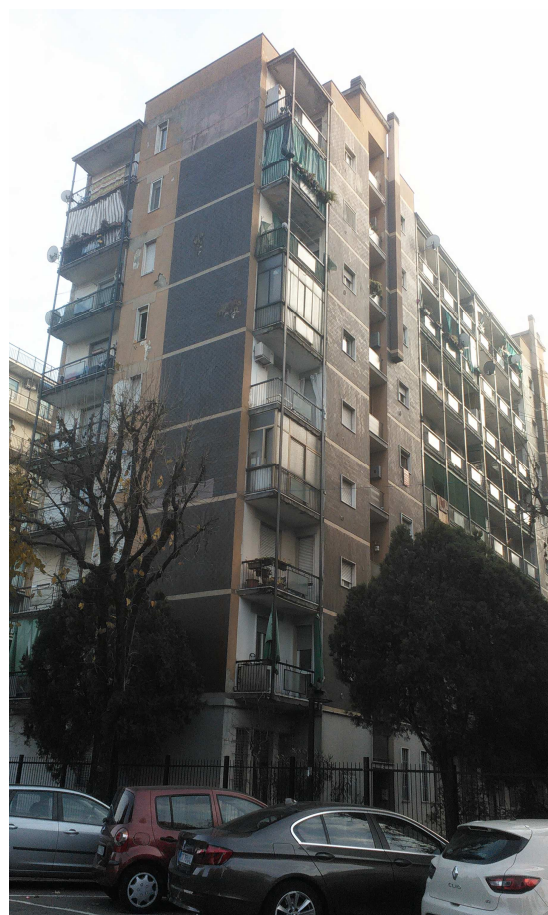
Foto n. 3 – Prospetto edificio C
