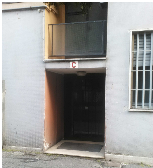
Foto n. 4 – Ingresso all’edificio C
